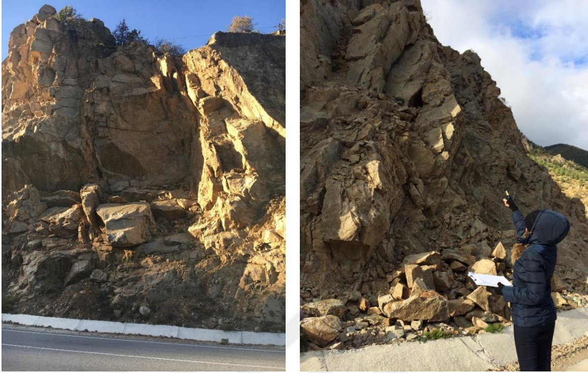
Şekil 2.14. Şevden kopup düşen blok görüntüleri
