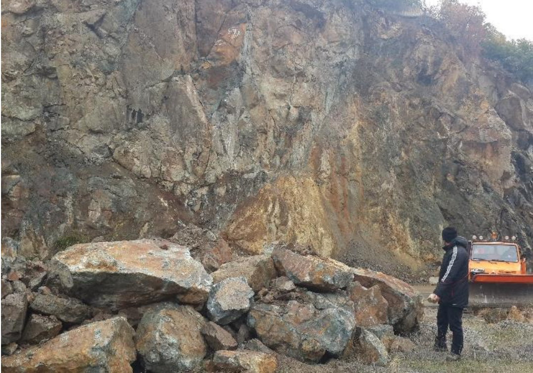
Şekil 2.13. Karayoluna düşen blokların iş makinası ile yol kenarına taşınması
