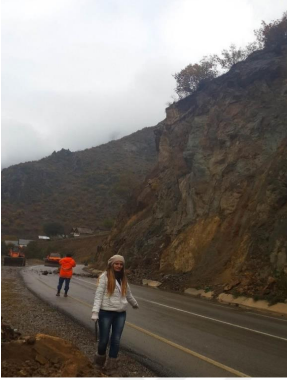
Şekil 2.10. Karayolu güzergahına şevlerden kopup düşen bloklar
