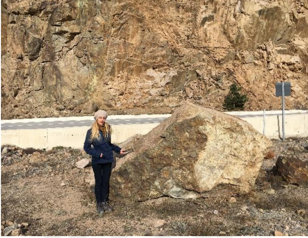
Şekil 2.12. Karayolu kenarına alınan düşmüş bir blok
