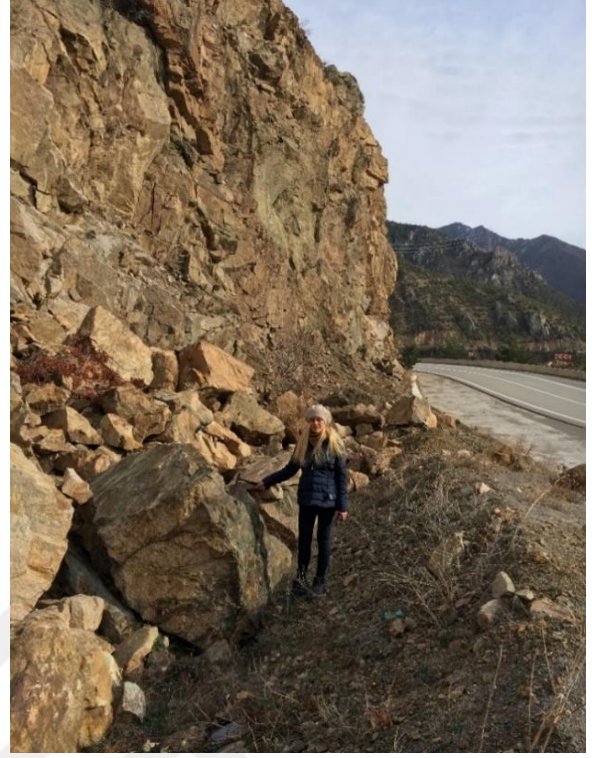
Şekil 2.10. Karayolu güzergahına şevlerden kopup düşen bloklar
