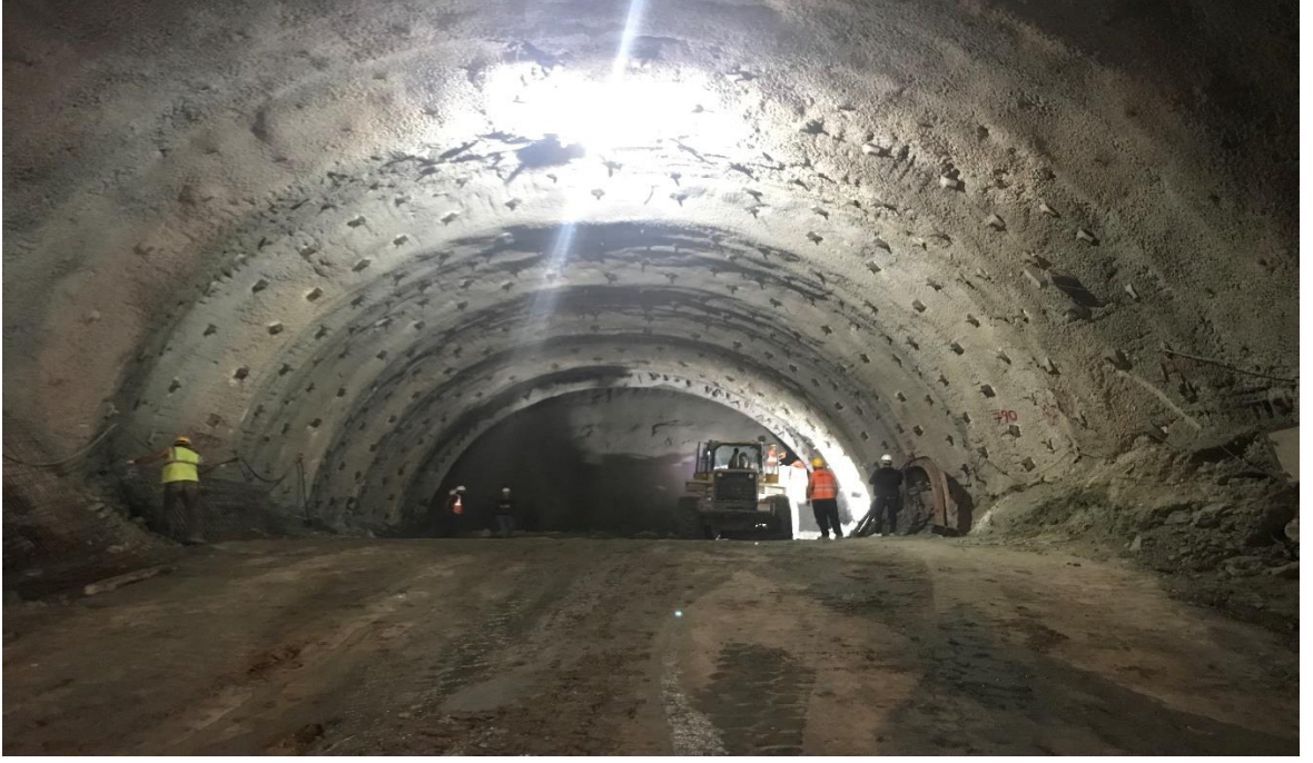
Görsel-3 Çekim sırasında açılan en uzun tünelde çekim yapılırken
