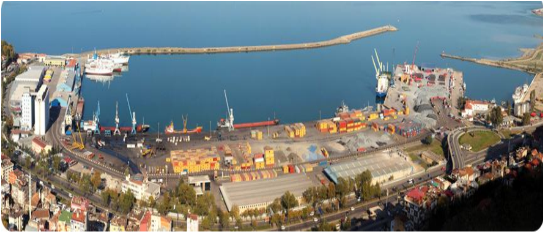
Şekil 8. Trabzon limanından bir görünüm (URL-20, 2012)
