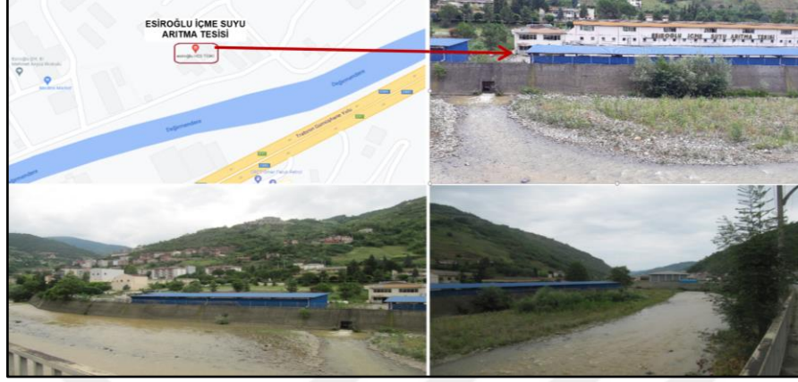
Şekil 7. Esiroğlu içme suyu arıtma tesisi
