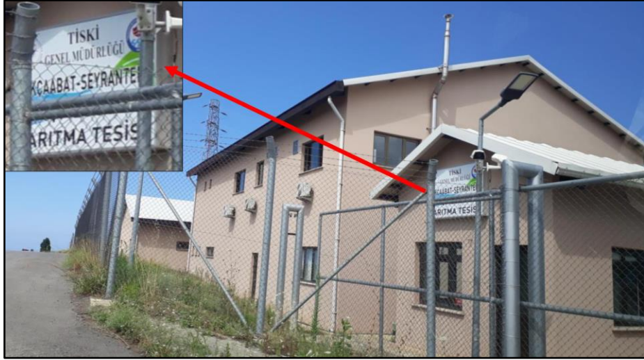
Şekil 10. Akçaabat- Seyrantepe içme suyu arıtma tesisi
