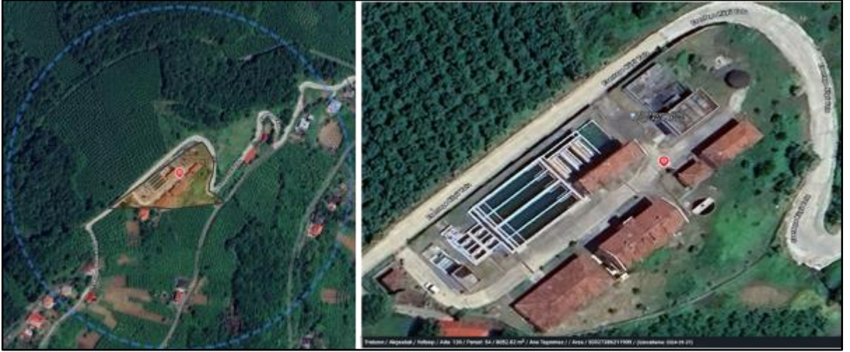
Şekil 13. Akçaköy- Derecik içme suyu arıtma tesisi
