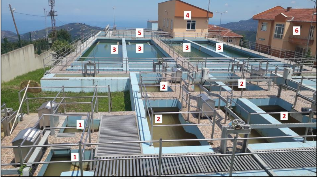
Şekil 15. Derecik içme suyu arıtma tesisi bölümleri (1:Hızlı karıştırıcı yapısı), (2:Yavaş karıştırıcı yapısı), (3:Çökeltme Havuzu), (4:Filtre pres binası), (5:Hızlı kum filtreleri) (6:Klor tüp ve kimya odası)
