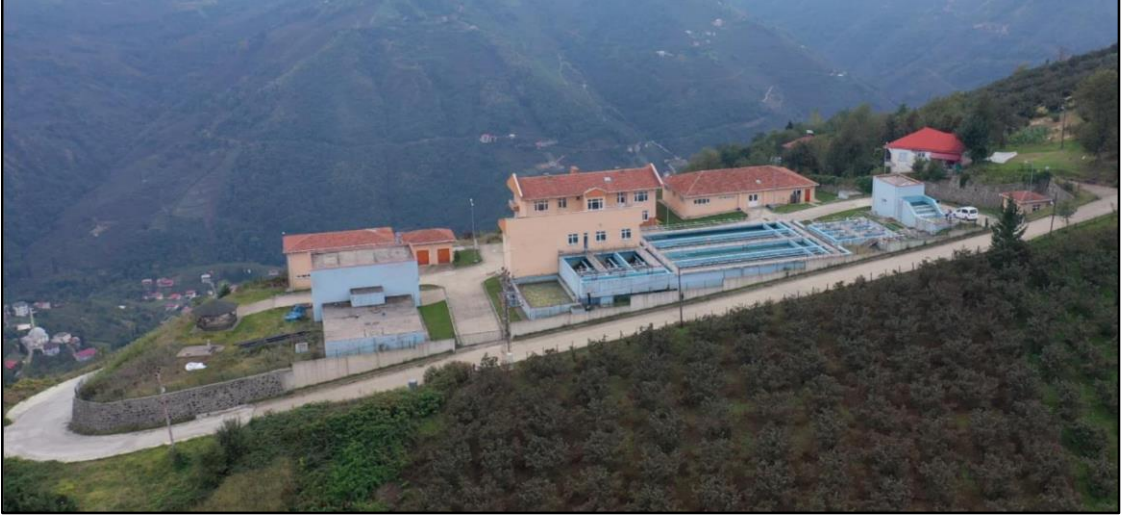
Şekil 14. Derecik içme suyu arıtma tesisi
