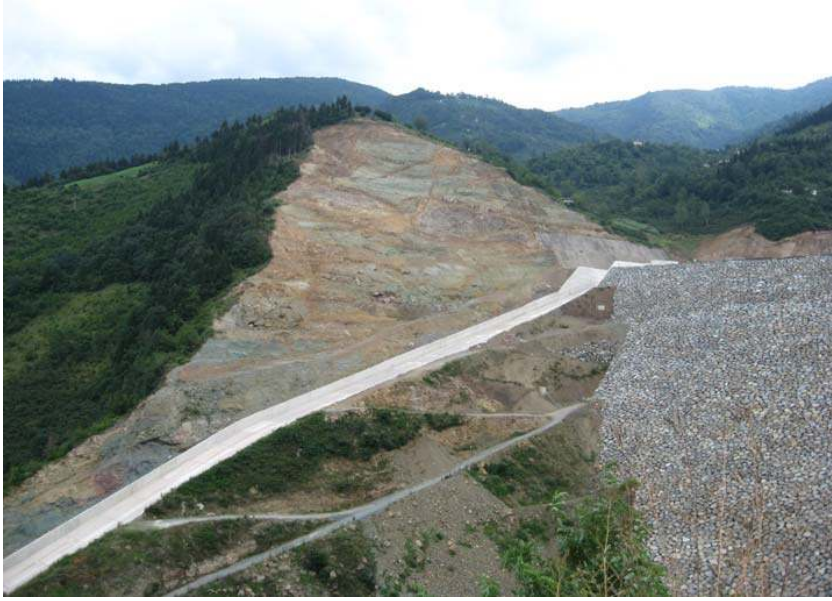
Resim 5.11. Atasu Barajı'nın yandan alışı dolusavağı ve gövdesinin mansap tarafından görünüşü
