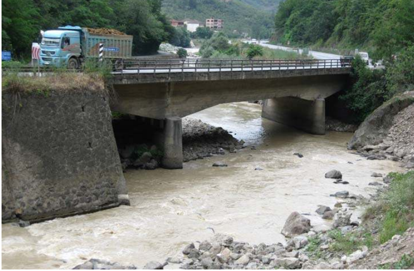
Resim 5.9. Nehir yatağındaki köprülerden, Değirmendere II Köprüsü
