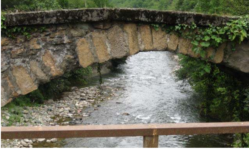
Resim 5.14. 22-86 No'lu AGİ'nin hemen mansabında bulunan Teraziler Köprüsü
