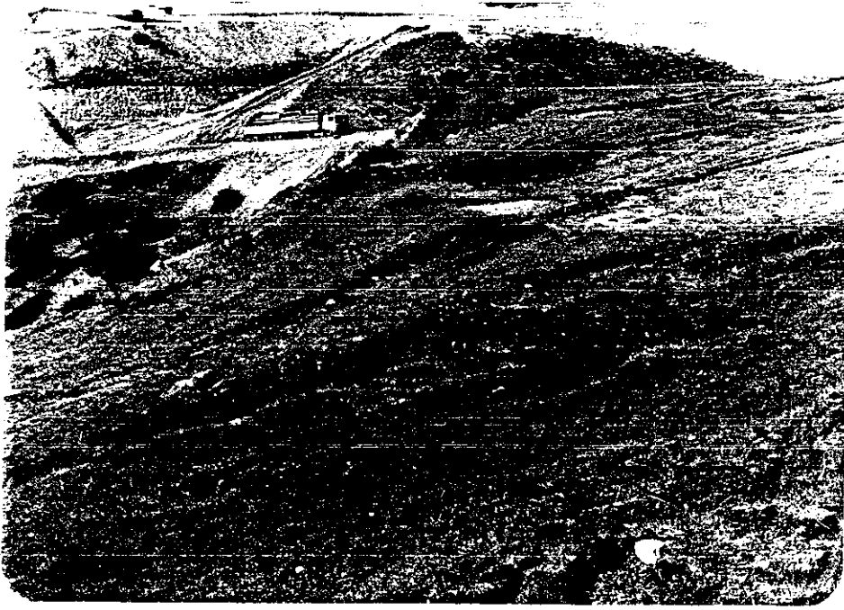
Foto 23- Birinci heyelan bölgesinde tansiyon çatlakları, oturma ve akmlar.
