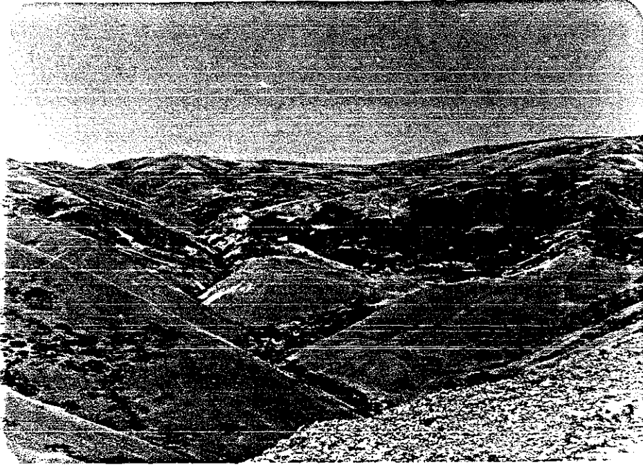
Foto 27- Kopdağı 1 ve 2 tünel güzergahları çıkış ağzı (Erzurum tarafı) üzerindeki üçüncü heyelan bölgesinin genel görünüşü. Mk :Kop ultramafiti, J-Kg :Gurri formasyonu, Hy :Heyelan.
