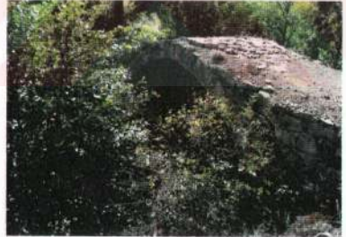
Şekil 38. İpek Yolu Dönemi'ne ait bir köprü
