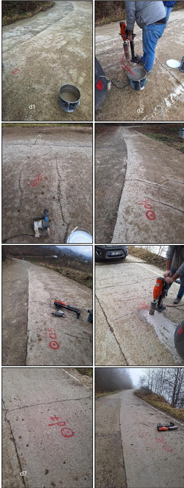
Şekil 33. Derecik mahallesinde belirlenen çalışma alanında çatlaklı kısımlara yakın bölgelerde alınan karot yerleri
