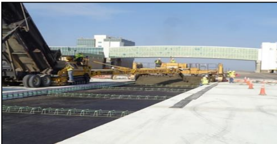
Şekil 9. Beton dökümü öncesi yolun son hali (Uyar ve ark, 2019).
