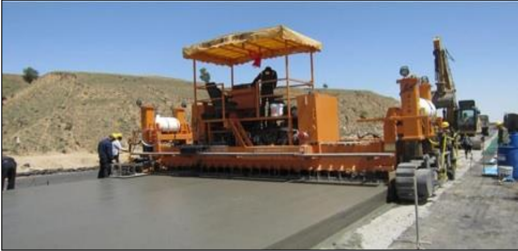
Şekil 10. Kayar kalıp ile betonun serilmesi (URL-6).
