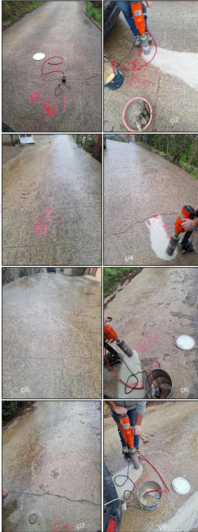
Şekil 34. Çiğdemli mahallesinde belirlenen çalışma alanında çatlaklı kısımlara yakın bölgelerde alınan karot yerleri
