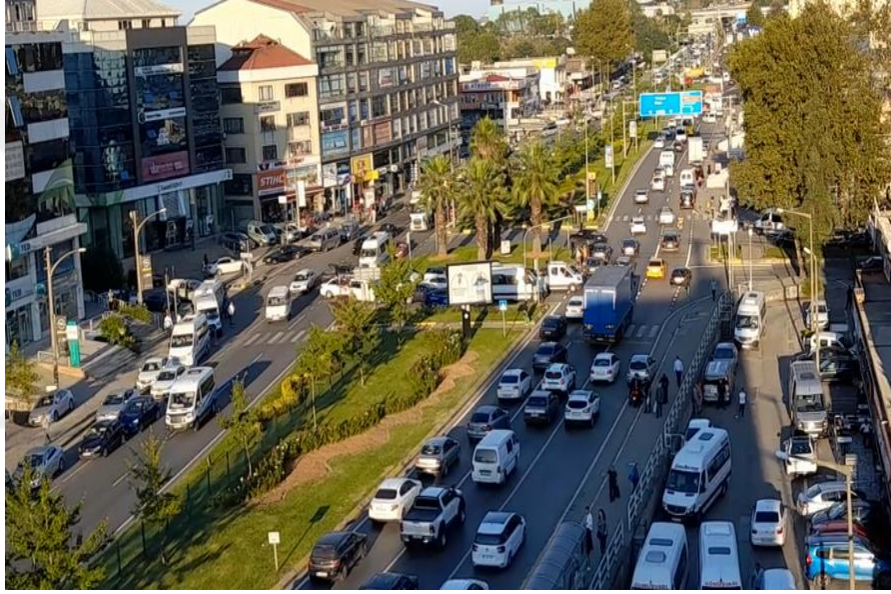
Şekil 2.14. Ada etrafında taşıtların beklemesi için bırakılan alanın yetersizliği
