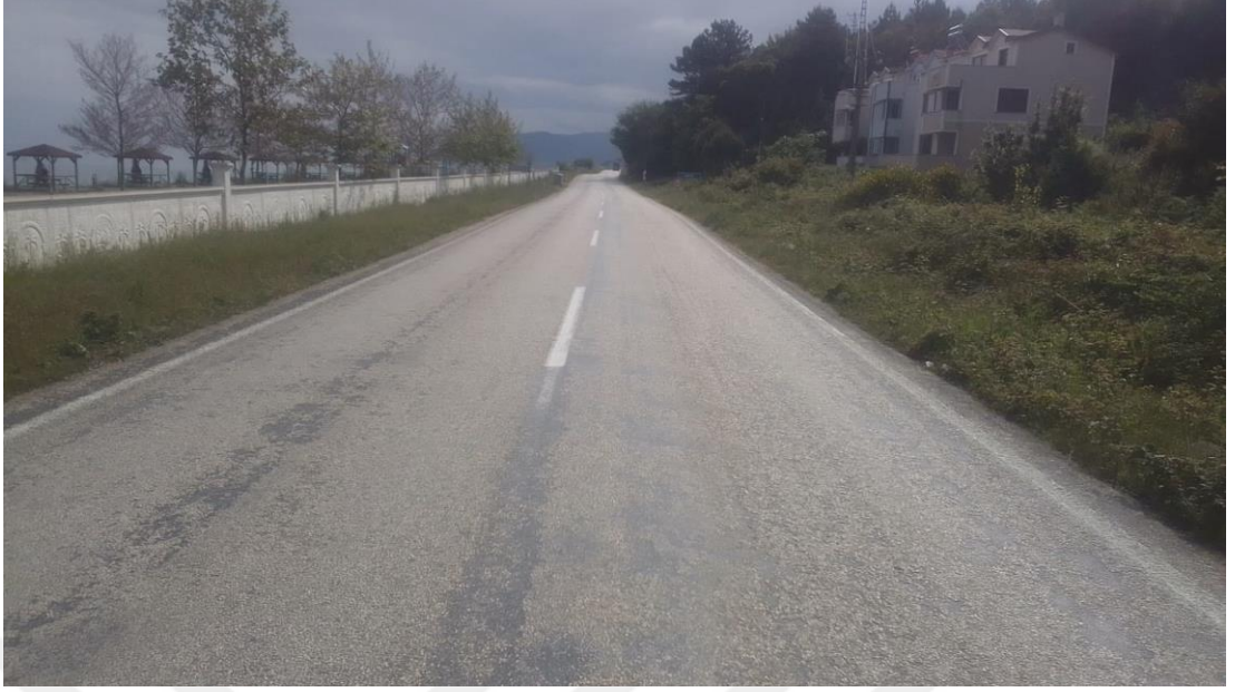
Şekil 4.55 010-09 Numaralı Yol Kesimi 16+000. Km
