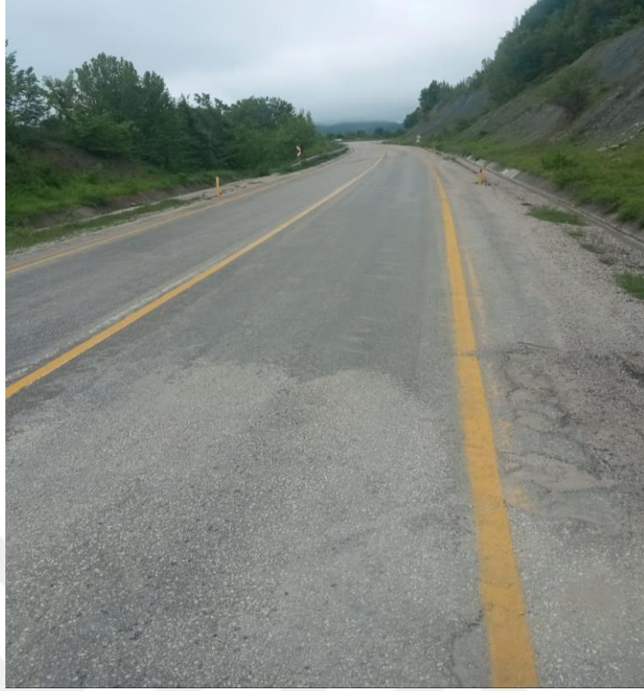
Şekil 4.61 759-01 Numaralı yol kesimi 10+000. Km
