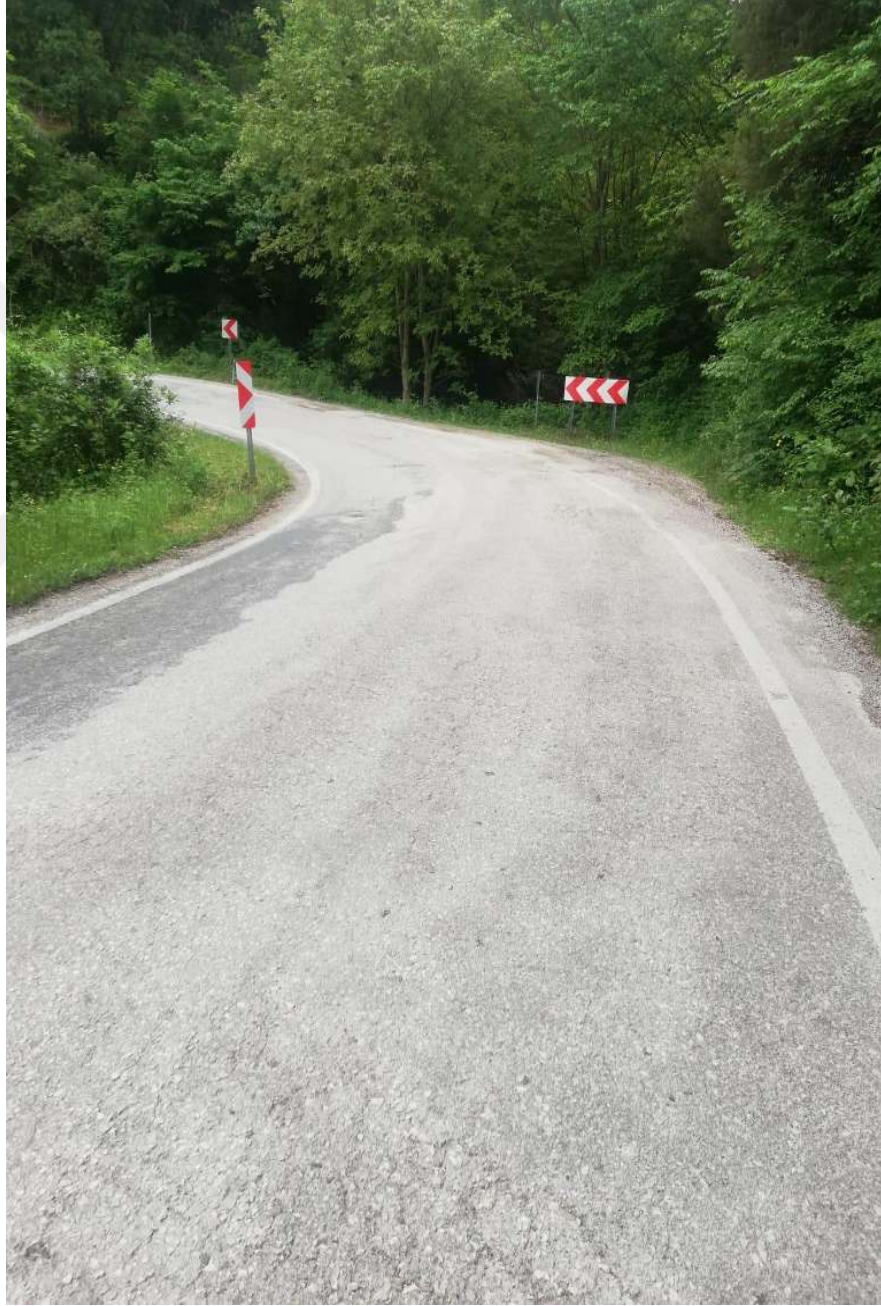
Şekil 4.58 010-10 Numaralı Yol Kesimi 11+700. Km
