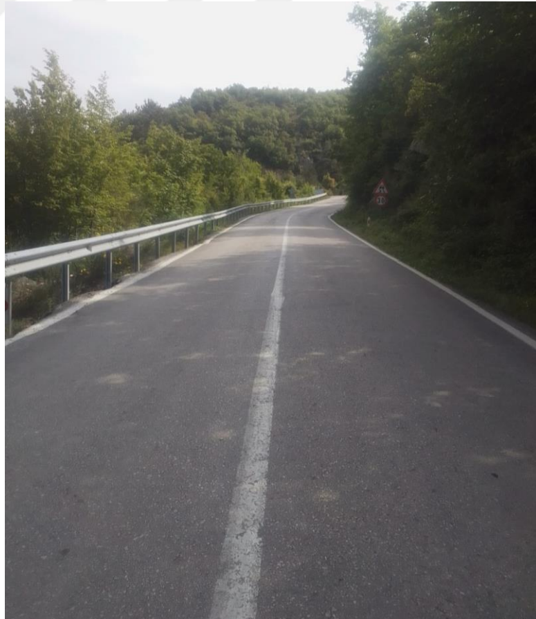
Şekil 4.54 010-09 Numaralı Yol Kesimi 12+200. Km
