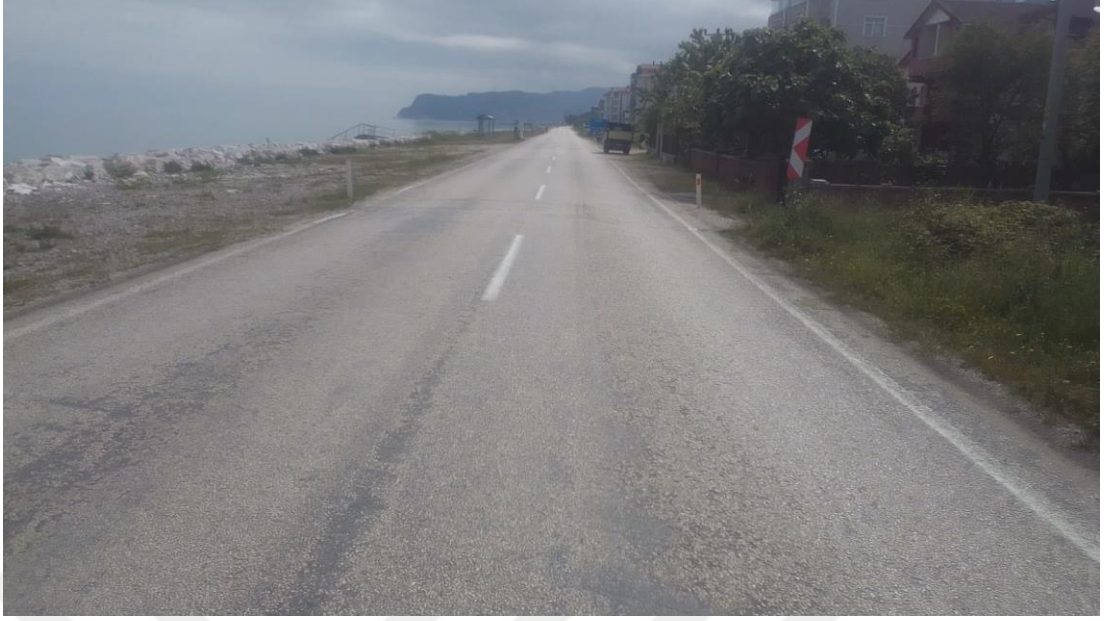
Şekil 4.57 010-09 Numaralı Yol Kesimi 16+300. Km
