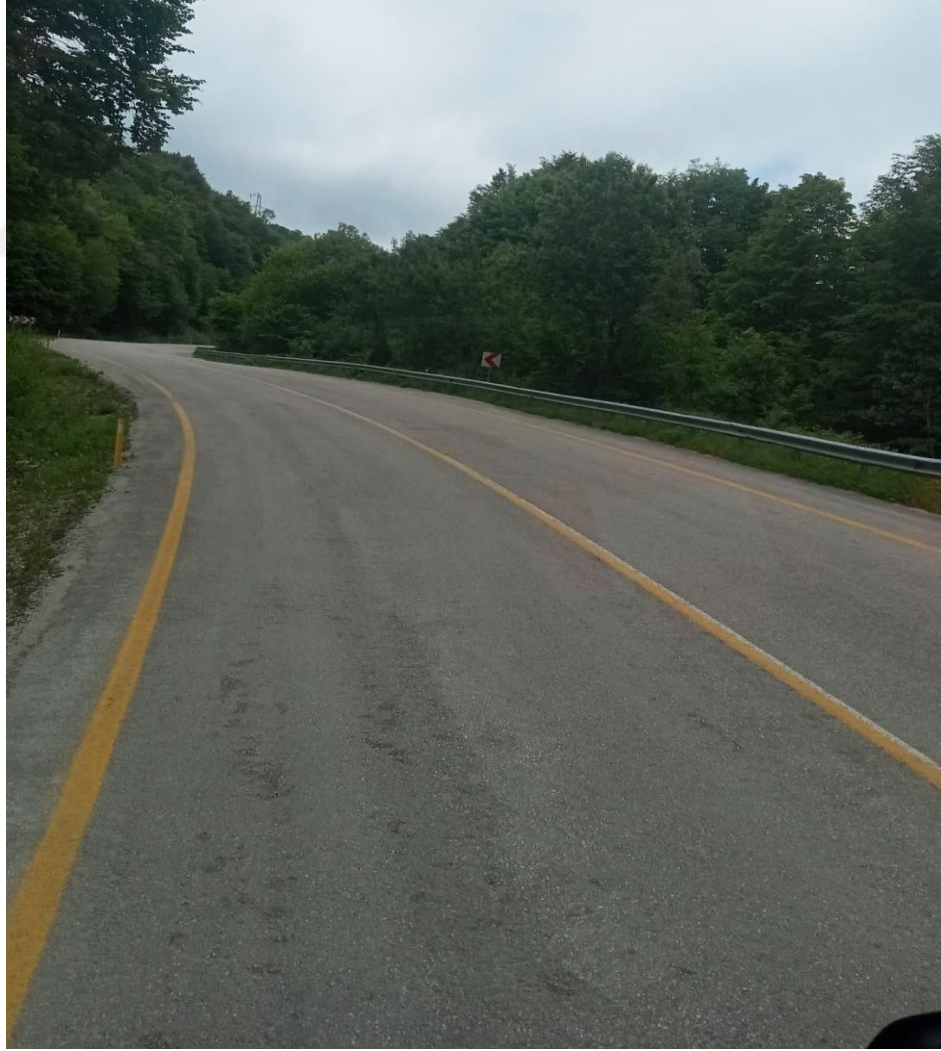
Şekil 4.64 759-01 Numaralı yol kesimi 16+300. Km
