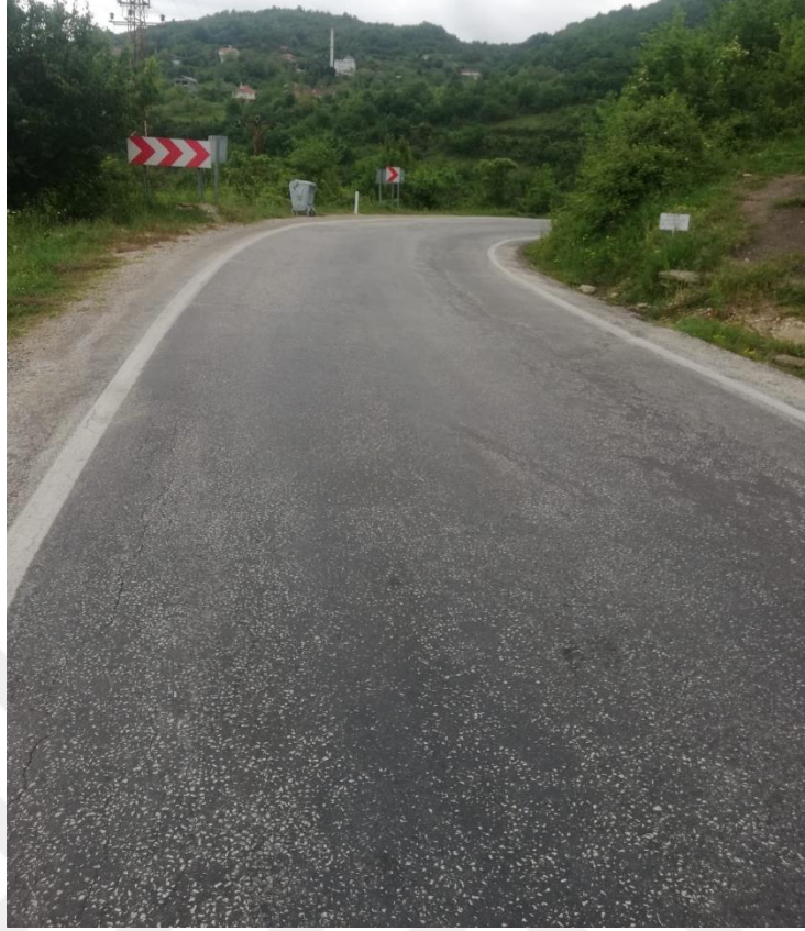
Şekil 4.59 010-10 Numaralı Yol Kesimi 11+800. Km
