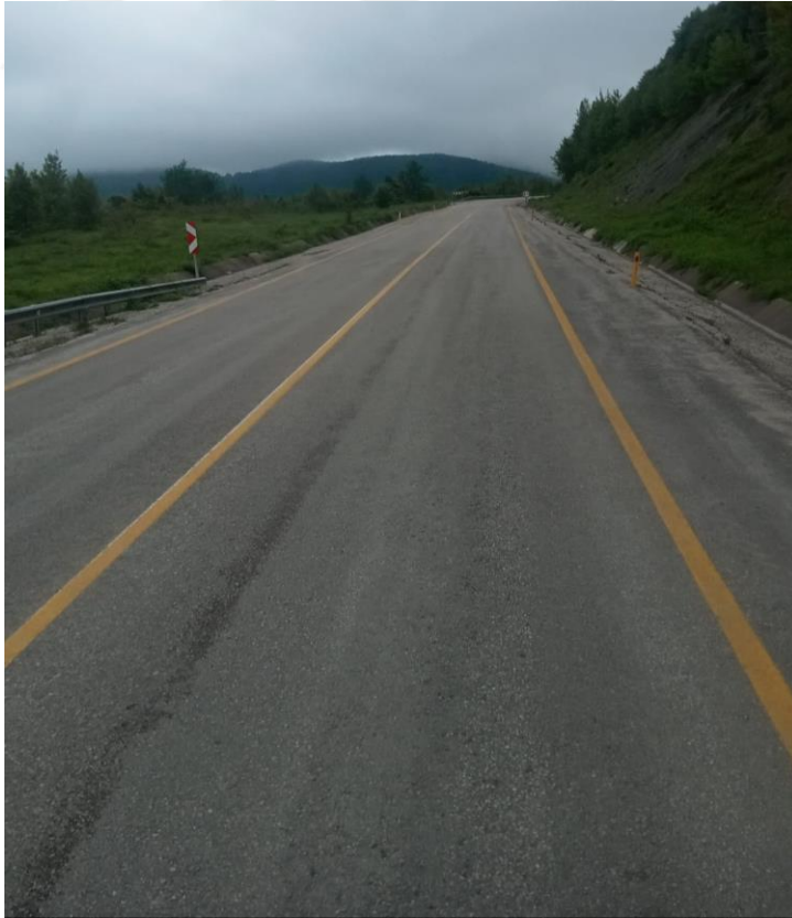
Şekil 4.62 759-01 Numaralı yol kesimi 10+300. Km
