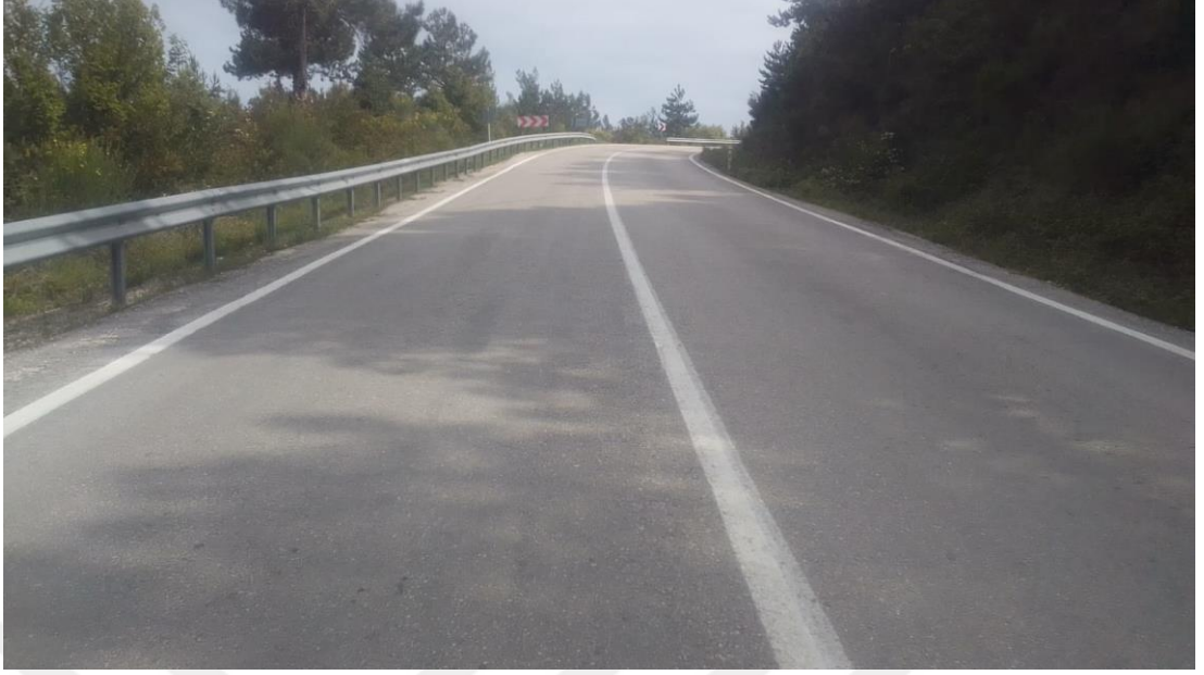
Şekil 4.53 010-09 Numaralı Yol Kesimi 12+700. Km
