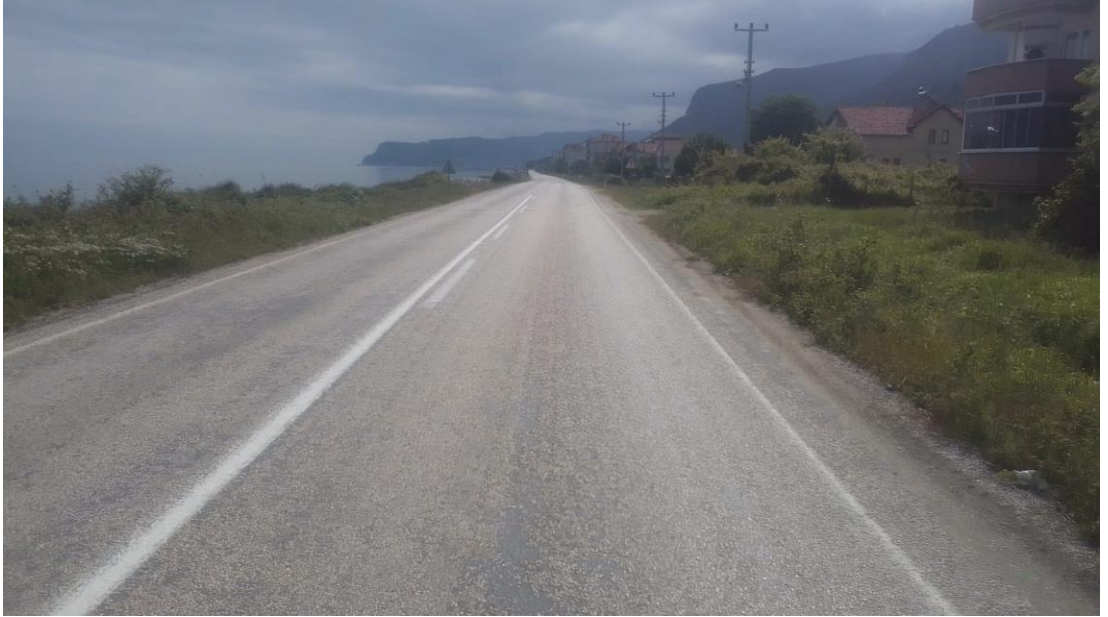
Şekil 4.56 010-09 Numaralı Yol Kesimi 16+600. Km
