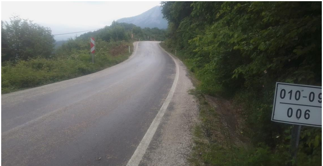
Şekil 4.52 010-09 Numaralı Yol Kesimi 6+000. Km
