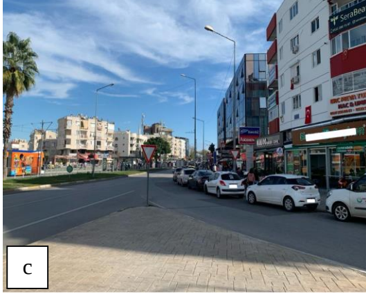
Şekil 4.57. Ali Çetinkaya Caddesi ile Mevlâna Caddesi'nin kesiştiği kavşak a) Kavşağın genel görüntüsü; b) Araçların kenara park etmesine ait görüntü; c) Araçların sinyale yakın bölgede park etmesine ait görüntü
