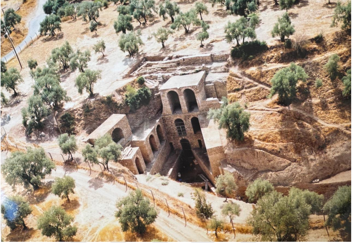
Resim 12. Arsenal olarak adlandırılan tnel ađı giriři, restorasyon sonrası grnm (Aydın Mzesi Arřivi, Tralleis 2001 Yılı Kazı Sonu Raporu)
