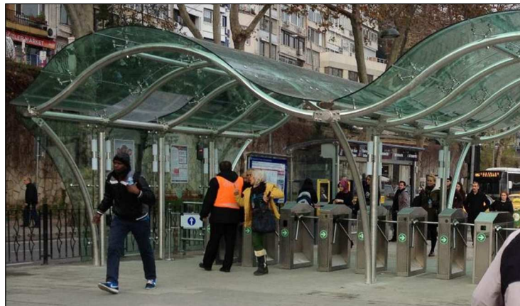
Şekil 3.34 : Bilet Makinesi ve Turnike Geçişi.
