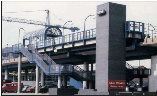
Şekil 3.36 : Docklands HRS’de Engelli Yolcu Asansörü.
