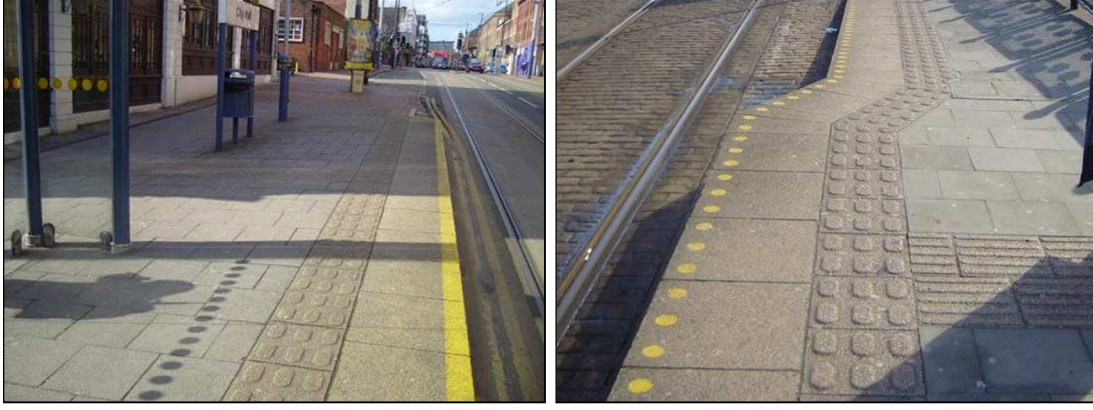
Şekil 3.32 : Hissedilebilir Zemin Uygulamaları – İngiltere
