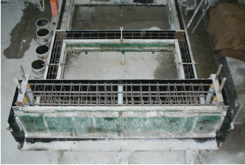
Resim 3.3. Kalıp içine yerleştirilmiş beton dökümüne hazır çerçeve donatısı
