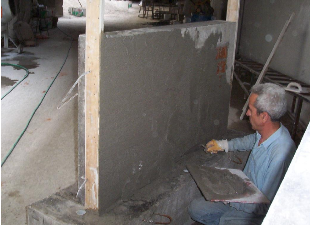
(b) Dolgu duvarın dış yüzünün sıvanışı
