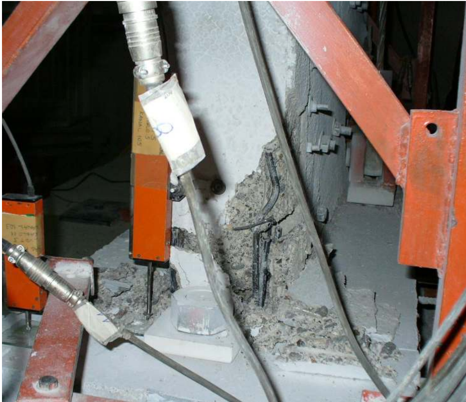
Resim 4.28. 21. çevrim sonunda saė kolon donatılarında gzlenen burkulma
