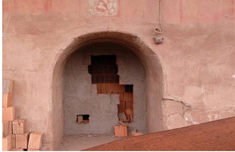
Şekil 4.28 Fırın girişinin pişirme sonrası açılması
