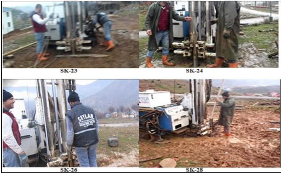
Şekil 2.2. Yapılan sondaj çalışmalarına ait saha görüntüleri (Tunceli 2.bölge imara esas jeolojik ve jeoteknik etüd raporundan alınmıştır).
