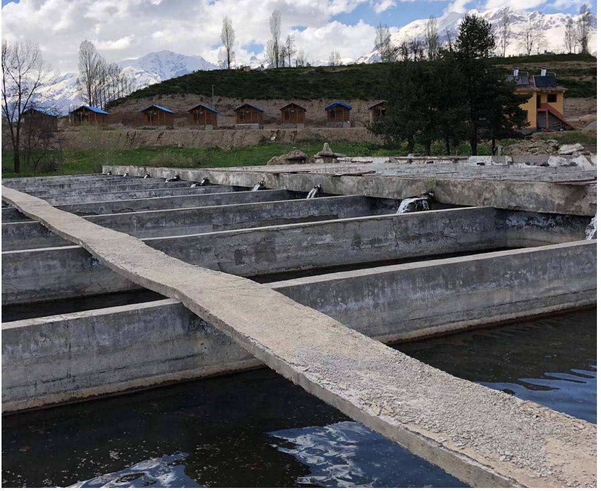
Şekil 3.12. Ovacık İlçesi'nde Kılınçoğlu alabalık üretim tesisleri.
