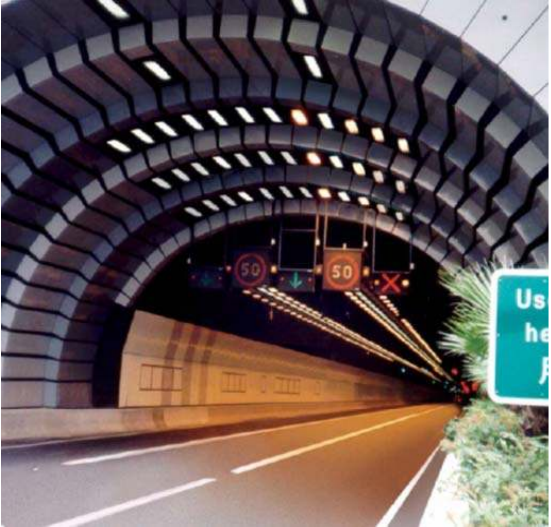
Şekil 4.1 Tünel aydınlatma tekniğinde büyük önem arz eden giriş bölgesi
