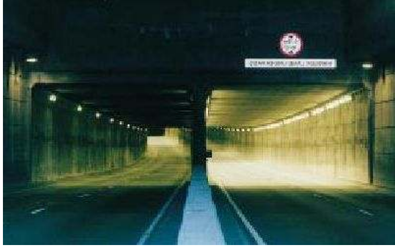
Şekil 4.11 Çift yönlü bir karayolu tünelinin giriş (sağ şerit) ve çıkış (sol şerit) bölgeleri
