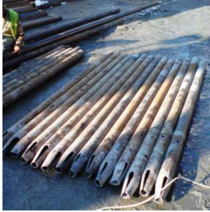
Şekil 2.12 Çelik boruların son hali
