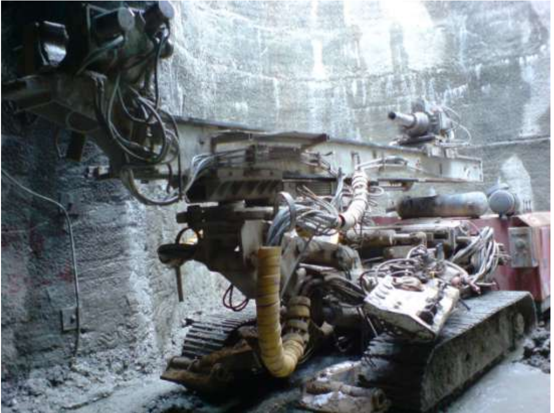
Şekil 2.9 4 inçlik boru deliklerinin delinebilmesi için kullanılan makine
