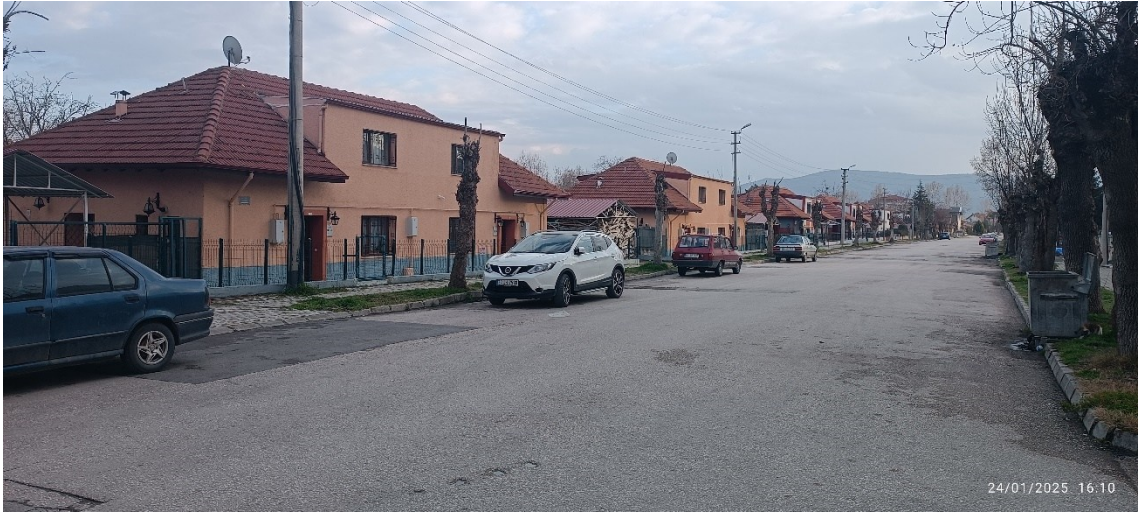
Şekil 3.19: Akasya Sokak'ta Bulunan Şehirleşmeye Örnek Oluşturması İçin Yapılan Lojmanlar
