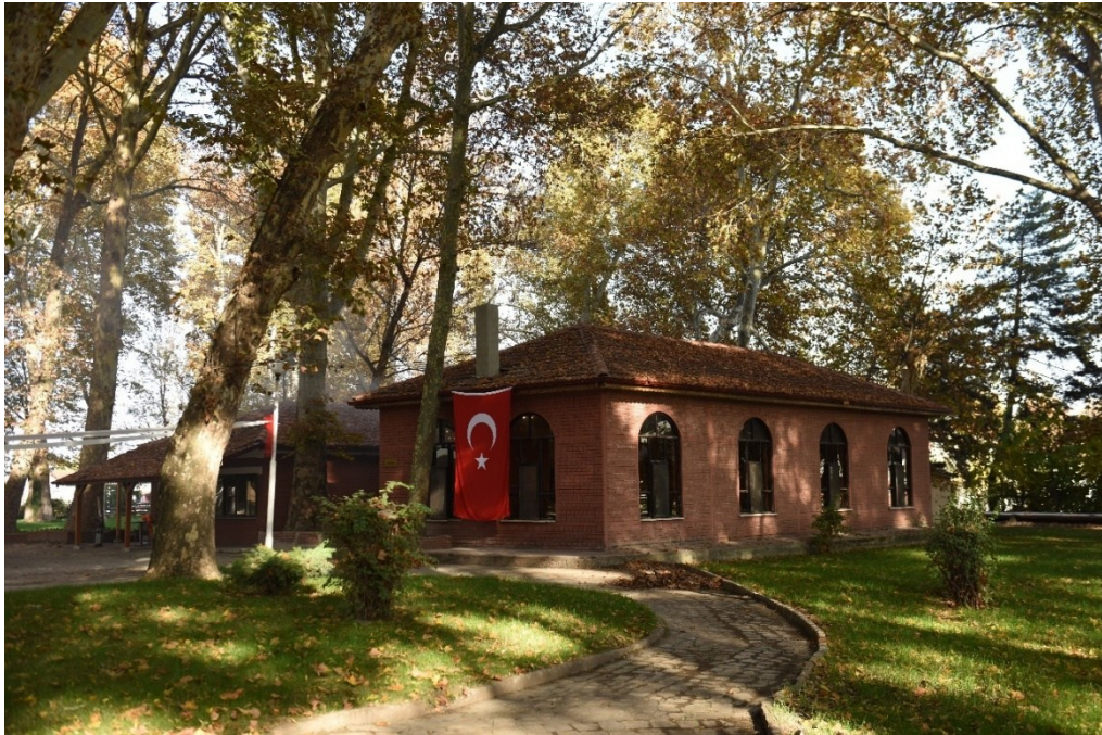
Şekil 3.28: Şeker Fabrikası Dağ Evi
