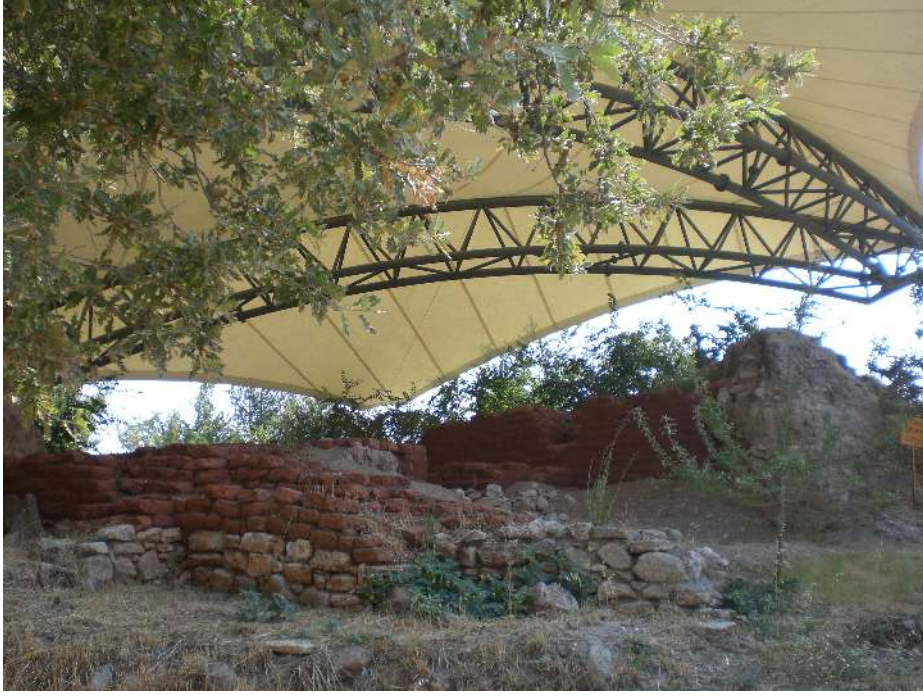
Resim 35: Troya II Surları Restorasyonu ve Üst Koruma Örtüsü (Serkan ATALAY Arşivi)
