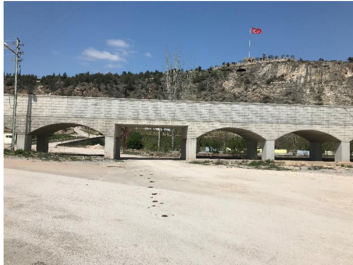
Şekil 5.9. DSİ yağmursuyu toplama kanalı-kırmızı yol kesişimi
