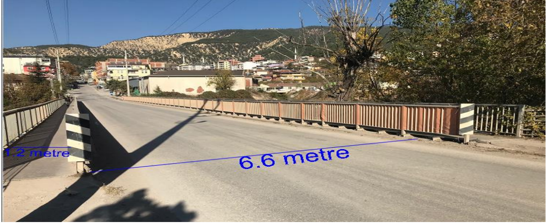
Şekil 4.12. Reşadiye Köprüsü'nün mevcut fotoğrafı
