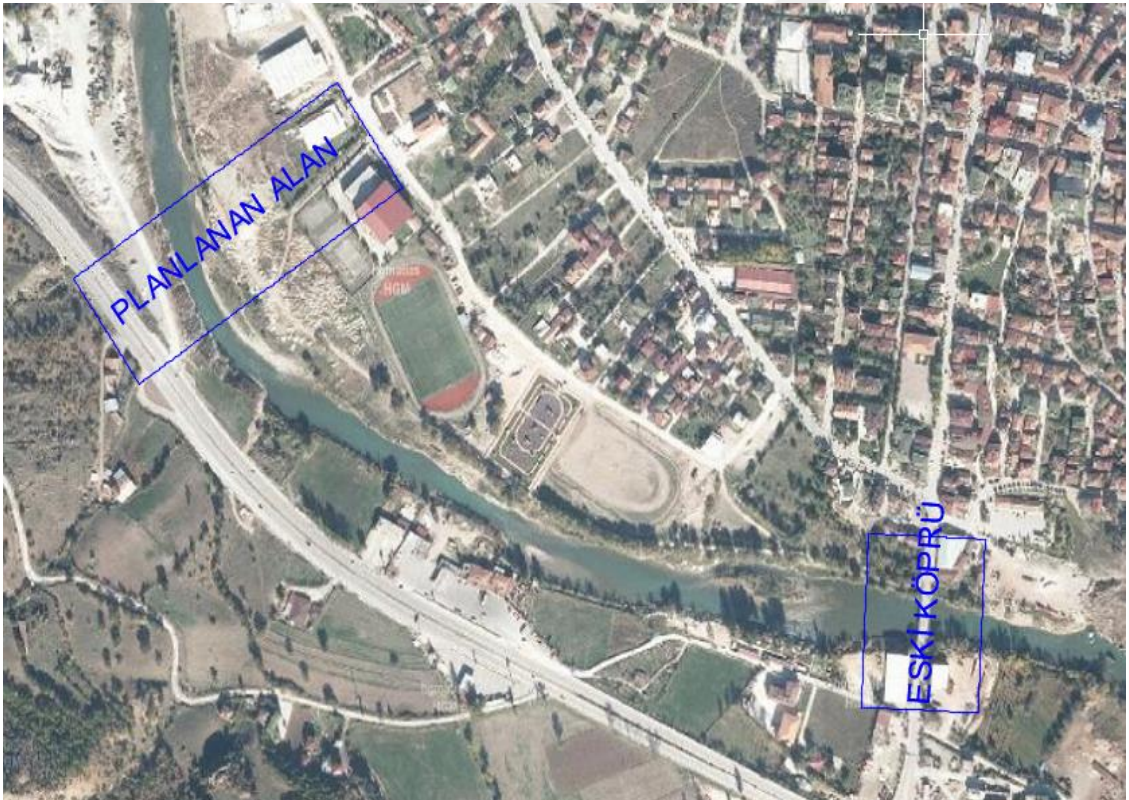
Şekil 6.1.Köprü için planlanan alan ve eski köprünün durumu
