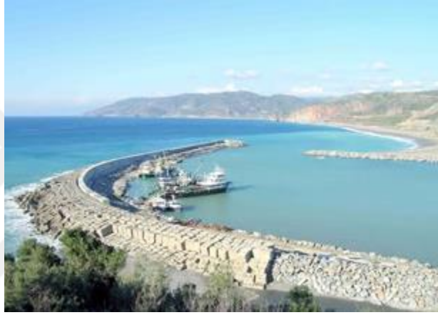
Şekil 3.14. Gazipaşa yat limanı inşaatı görüntüsü
