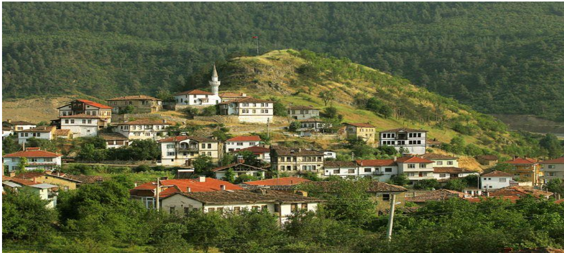
Resim 1: Taraklı İlçesi Osmanlı Evleri
