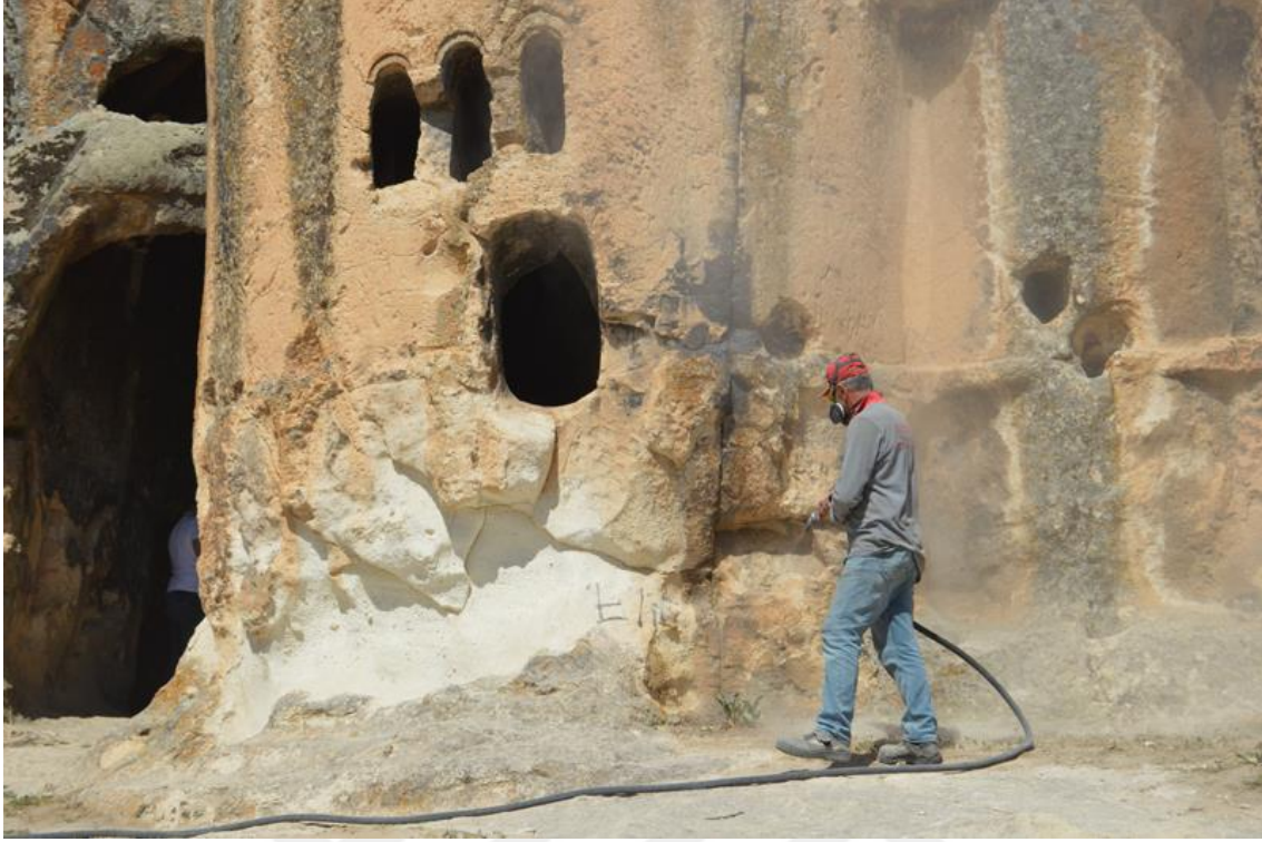
Resim 3. Ayazini Köyü Frigya kaya yerleşimlerinde yüzey temizliği ve restorasyon çalışması.
