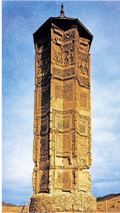
Resim.12 Sultan III. Mesut minaresi, Zafer Kulesi, 12.yy.
