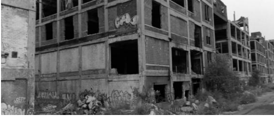
Görsel 4.62. Yıkık binalar
