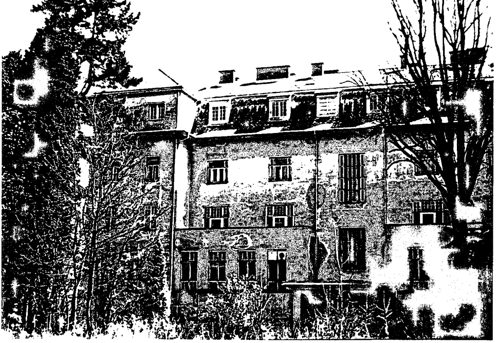
Resim 3.85 Purkersdorf Sanatoryumu 1904-1905, J. Hoffmann
