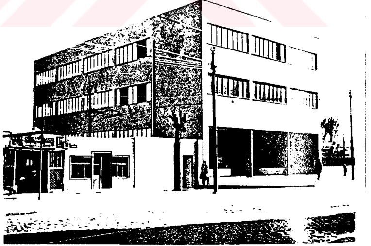
Resim 3.137 Satie Depo Binası, (1934) S.H. Eldem
