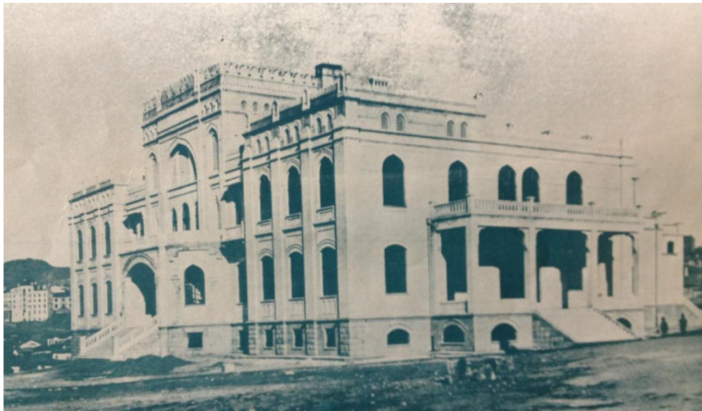
Resim 3.27. Türk Ocağı Merkez Heyeti Binası [61]
