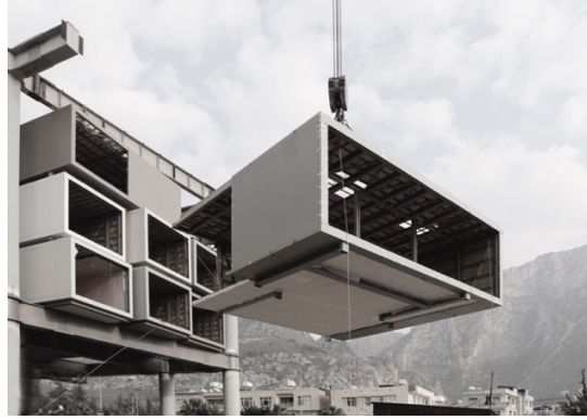
Şekil 3.31 : Antakya Müze Projesi oda modüllerinin vinç yardımı ile yerine taşınması (EAA, 2015).
