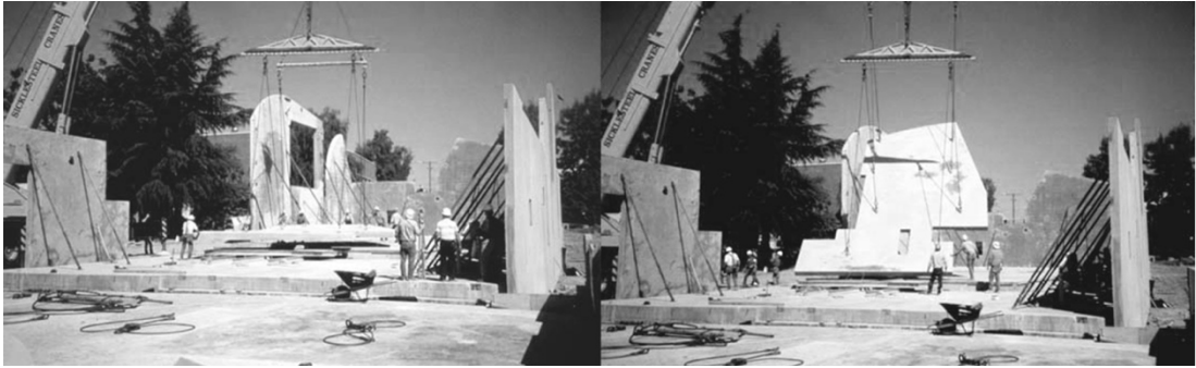
Şekil 3.24 : Şapelin duvarları yerine dikilirken bir görsel (Url-24).
