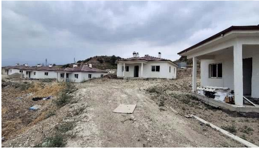
Şekil 4.73. ON-K22, Osmaniye Nohuttepe Köyü Kalıcı Konutları (Yazar Arşivi)
