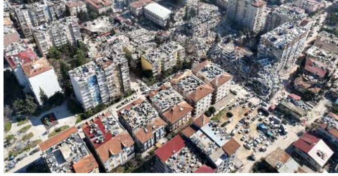
Şekil 4.9. 2023 KD Sonrası Hatay’da Gözlenen Yapısal Hasarlar (AFAD, 2024)
