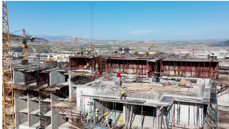
Şekil 4.19. Adıyaman İndere'de Tünel Kalıp Sistemi ile Üretilen Kalıcı Konutlar (URL-14)
