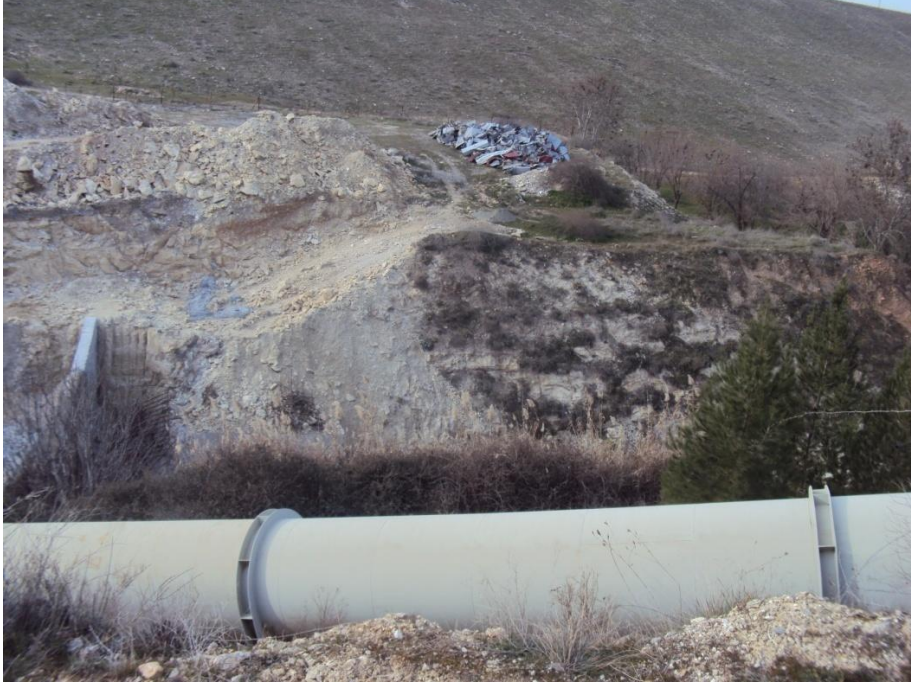
Hancağız Barajı- Baraj Kazası 2012, Gaziantep- 18 Ocak 2013
