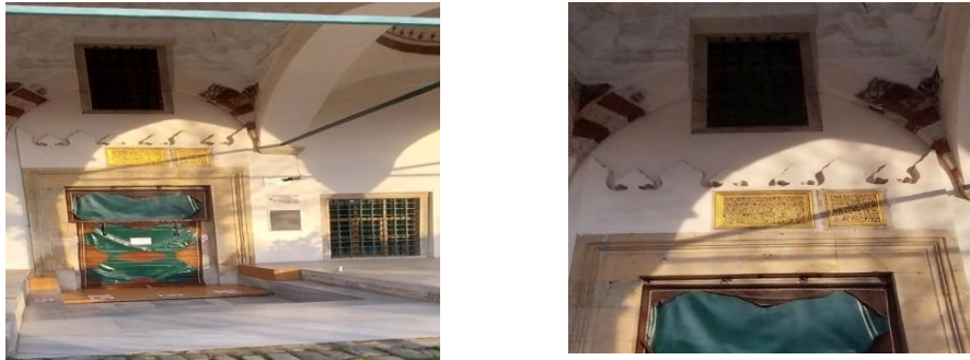
Resim 68: Küçük Ayasofya Camii Giriş Kapısı
