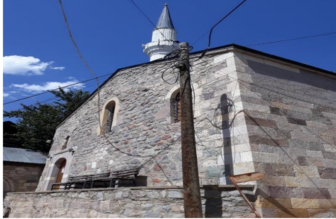
Resim 141: Gümüşhane Ayasofya Camii Dıştan Görünümü
