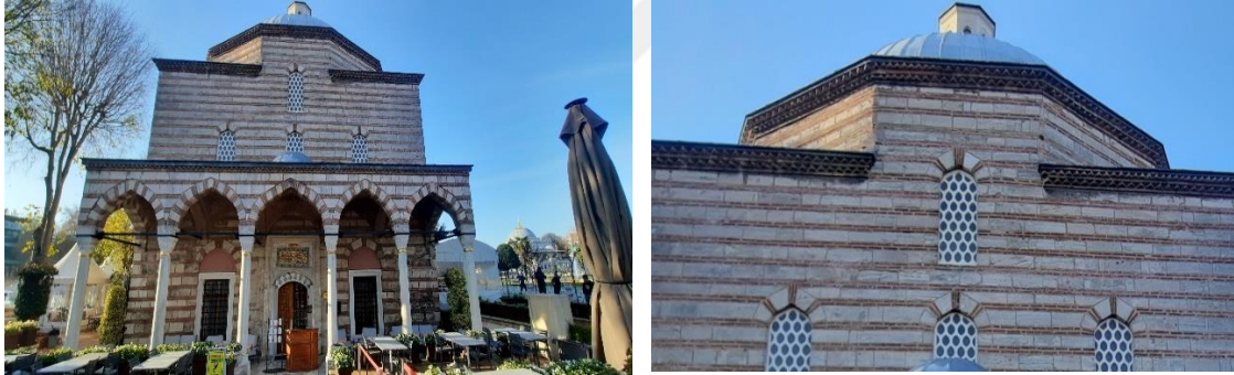
Resim 67: Narteks ile Duvar Örgüsü ve Kubbenin Yakından Görünüşü
