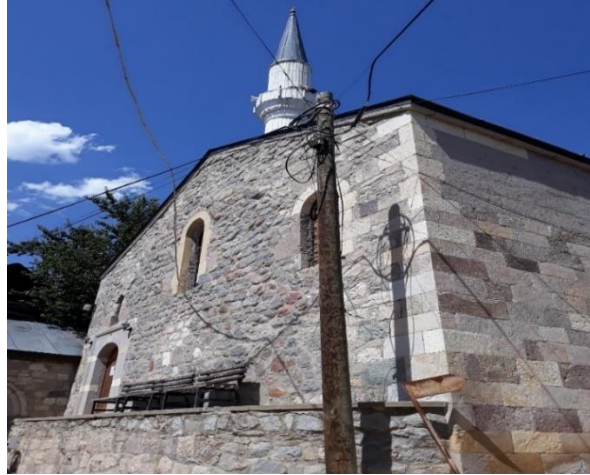
Resim 133: Duvarlarda Kullanılan Farklı Tekniklerin Birarada Görünümü
