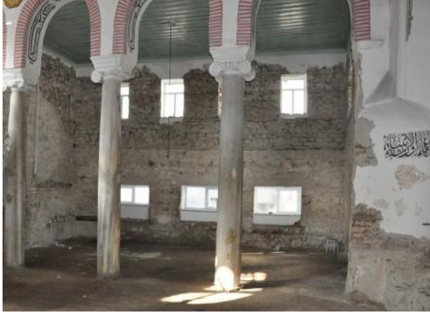
Resim 143: Zonguldak Ereğli Ayasofya Camii Tadilat Çalışmaları
