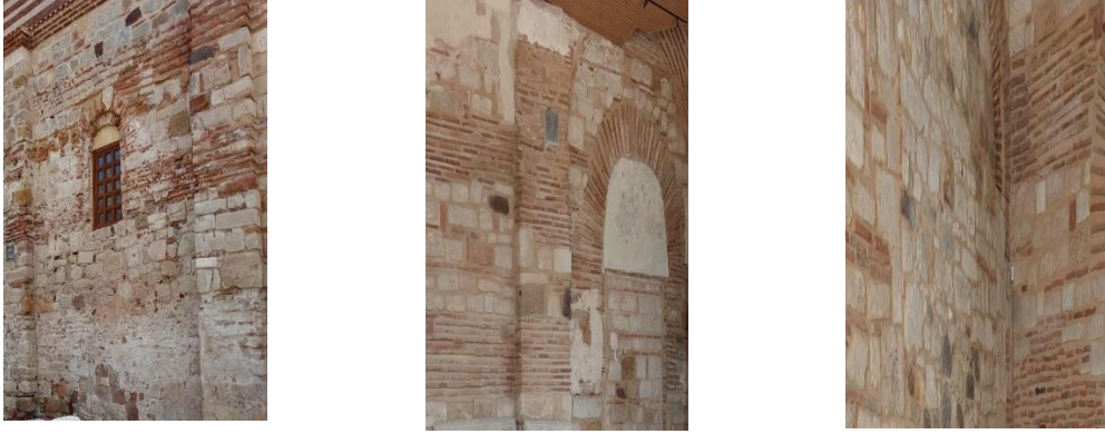
Resim 81: Enez Ayasofya Camii Duvarları
