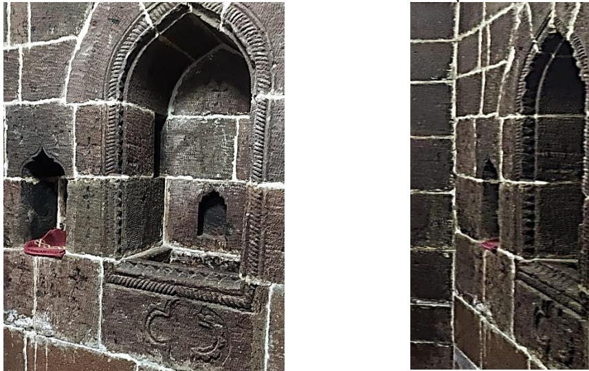
Resim 162: Duvarlarda Bulunan Nişler
