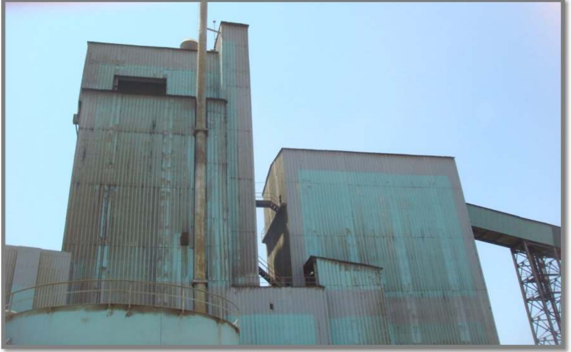
Foto 9: Kömür Değirmeni Ünitesi Dış Görünüm
