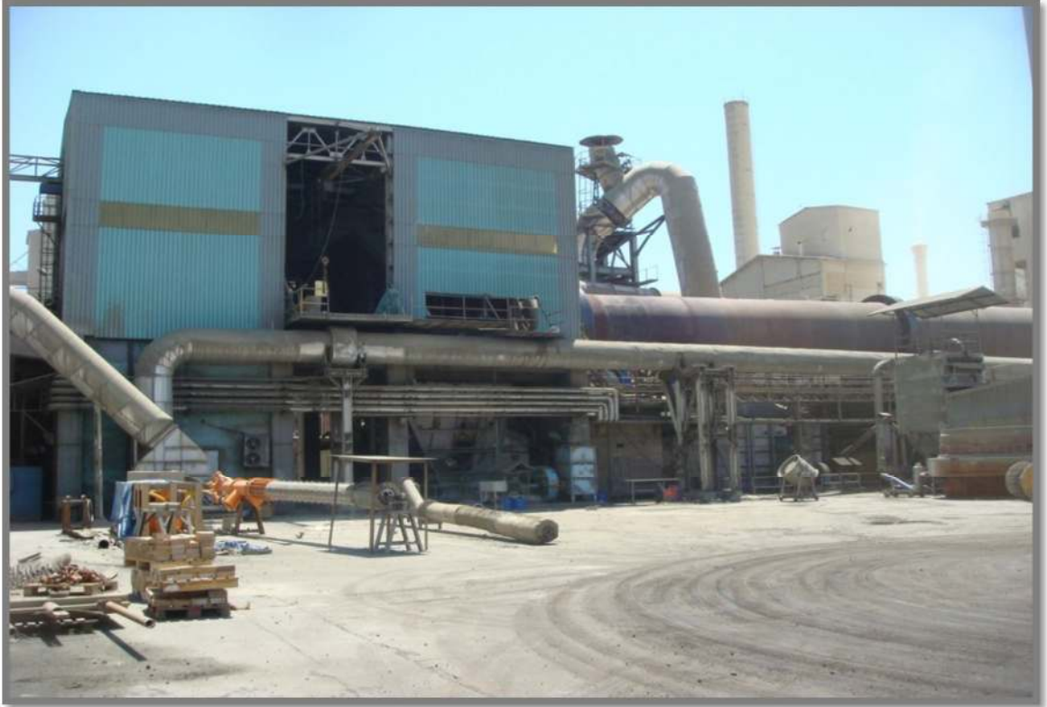
Foto 11: Döner Fırın ve Ayna Bölümü (Pişen Malzemenin Soğutmaya Döküldüğü Yer)
