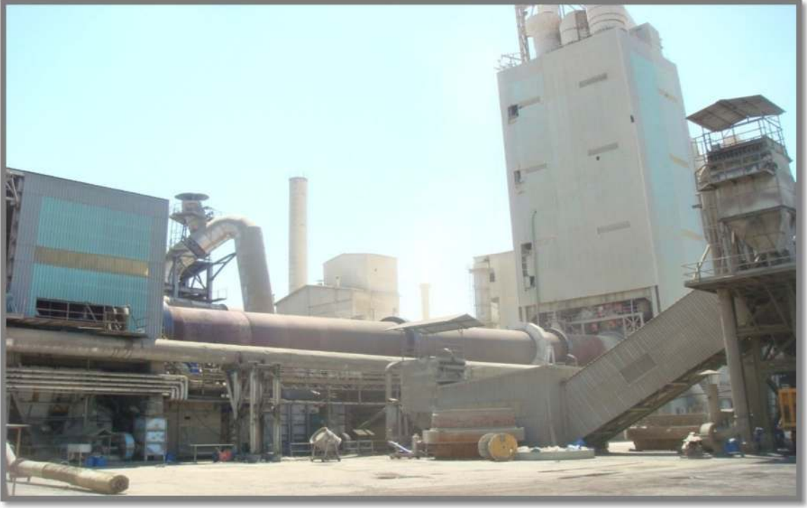
Foto 12: Döner Fırın ve Siklonlar 1-2-3-4 ve Ayna Karşidan Görünüm Scanner Kulesi Fırın Dış Manto Sıcaklığını Ölçer
