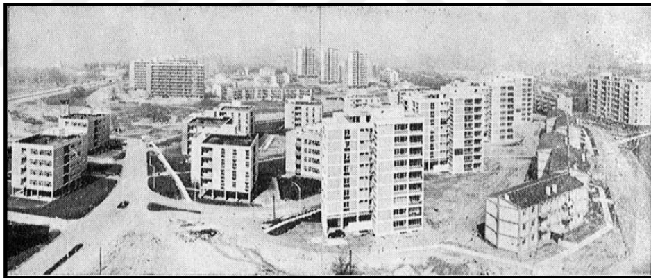
Figure 3.12: The Ataköy Development. (Source: Ataköy Sahil Şehri. (1965). Mimarlık , (1), 17.)
