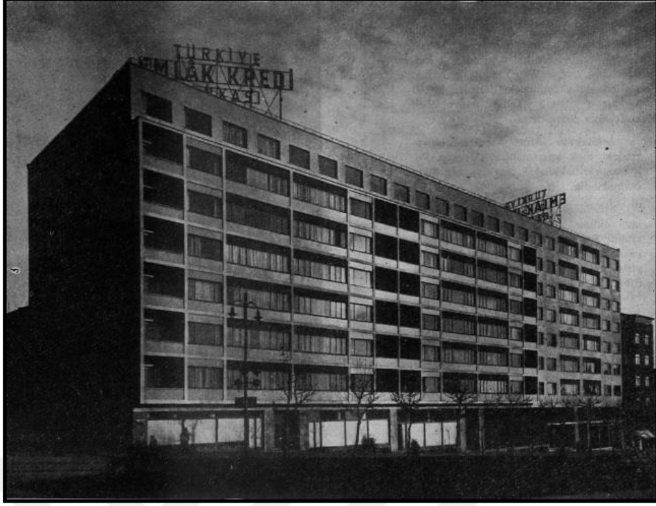
Figure 3.10: Aksaray Block Apartments on Atatürk Boulevard. (Source: İstanbul Belediyesi - Türkiye Emlâk Kredi Bankası Blok Apartmanları - Atatürk Bulvarı. (1957). Arkitekt , (1), 13.)
