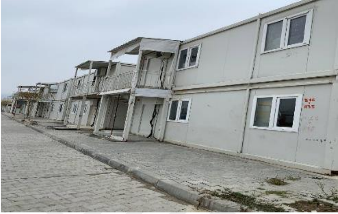
Görsel 24. Numaralandırılmış Konteynerlerden Oluşan Bir Sokak Görüntüsü
