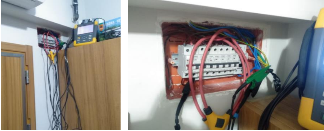
Şekil 2.2. Ölçüm düzenek yapısı
