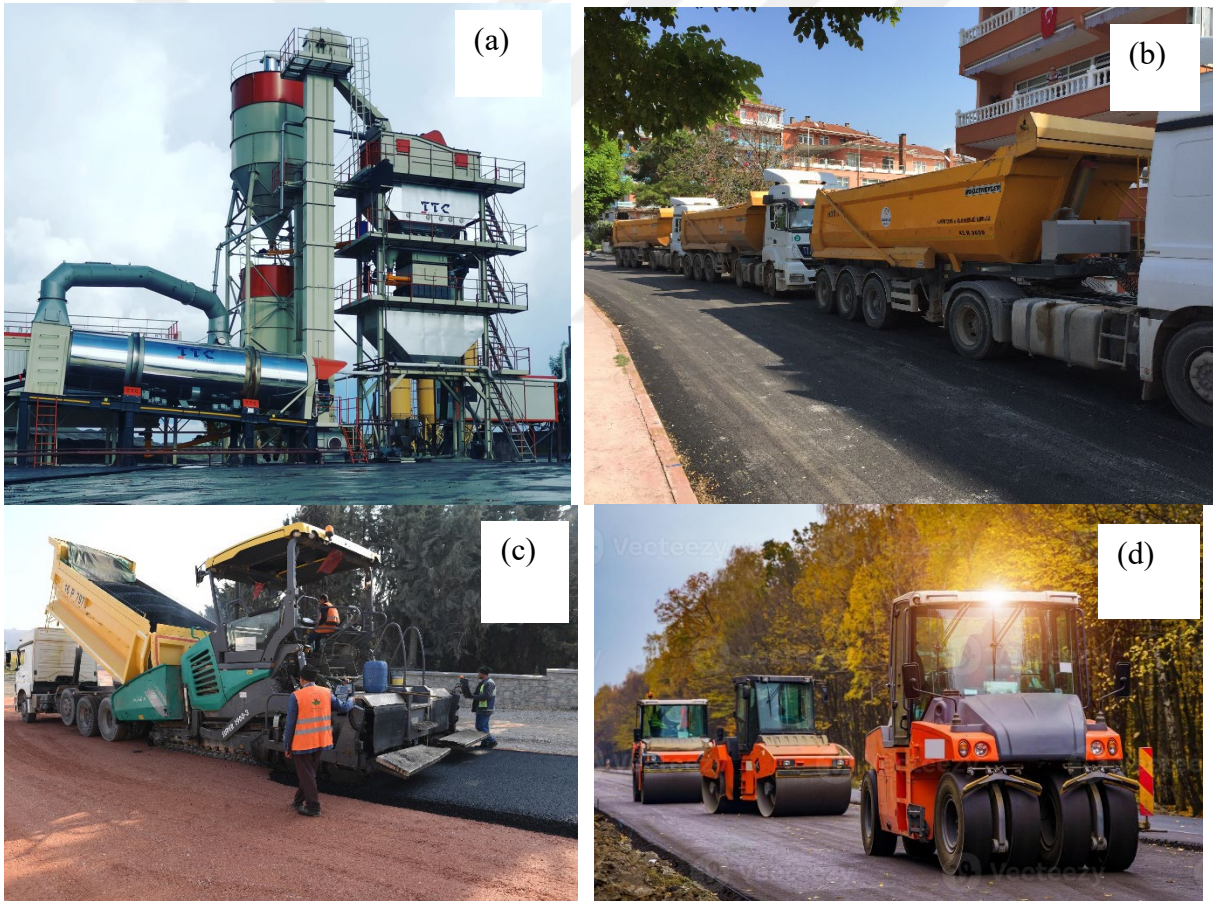
Şekil 2.1 : BSK kaplama imalat aşamaları a) asfalt üretim tesisi (plant) b) taşıma aşaması c) finişer ile serilme aşaması d) sıkıştırma aşaması
