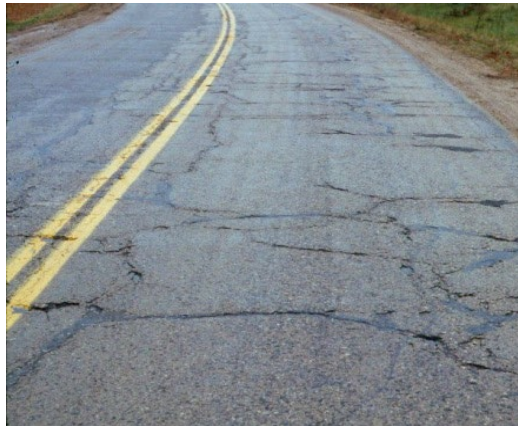
Şekil 2.7: Stabilite(kalıcı deformasyona karşı direnç) çatlakları
