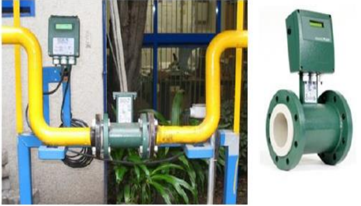
Şekil 3.9. Montajı yapılmış EMD örneği (Baykan 2017)
