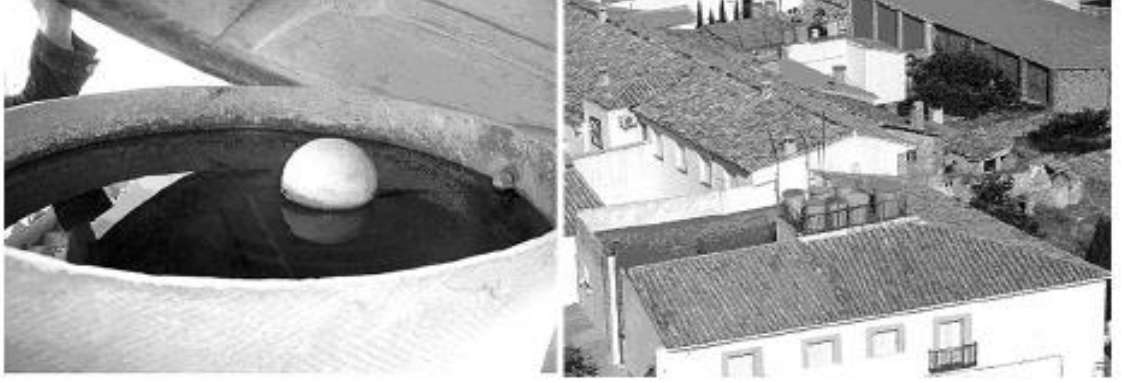
Şekil 3.23. Bina çatılarında yer alan özel depolama tankları (Arregui vd. 2006)
