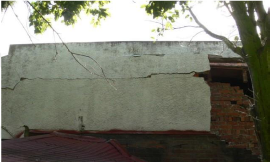
Şekil 1.1 Canterbury depreminde kemerlenme davranışı gösteren duvar (Dizhur ve Ingham, 2015)
