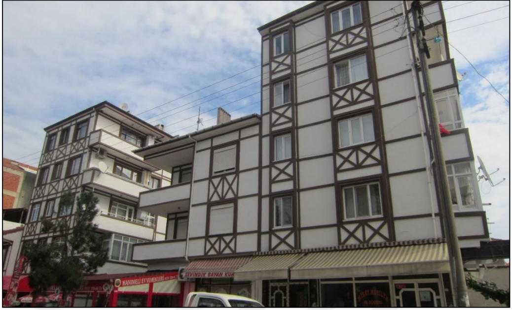
Resim 23. Yalova (Göçmen Mahallesi). Şehir Merkezinde Farklı Renklere Boyanmış Binalar
