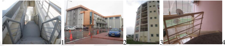
Şekil 4.30. Hibrit 1 (1), Tekno 3 (2) ve Yazılımkule (3 ve 4) yangın merdivenleri
