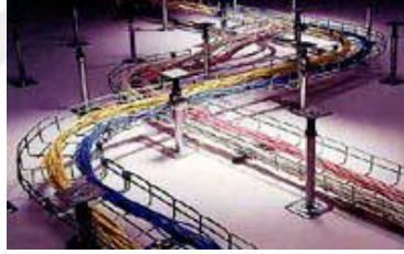
Şekil 2.88. Yükseltilmiş Döşeme Sistemi (Varlı 2004)
