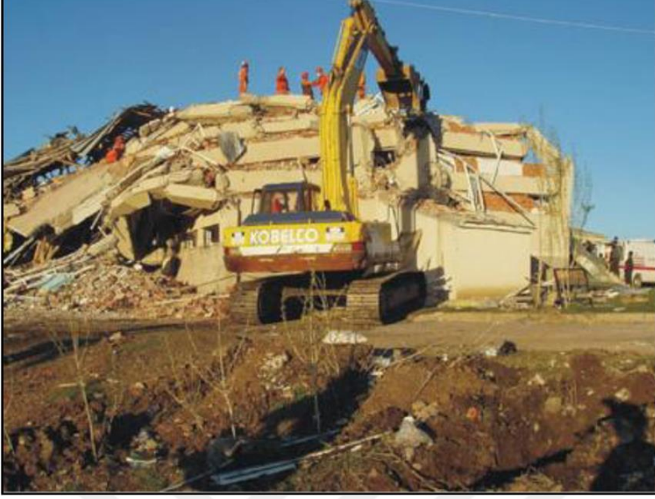
Şekil 3.15. 2003 Bingöl depreminde tamamen çökmüş ve 84 öğrenci ile 1 öğretmenin ölümüne yol açmış olan Çeltiksuyu Yatılı Bölge Okulu pansiyon binasının enkazında görev alan arama kurtarma ekipleri ve iş makinelerinin eş zamanlı çalışması (Temizer, 2013).
