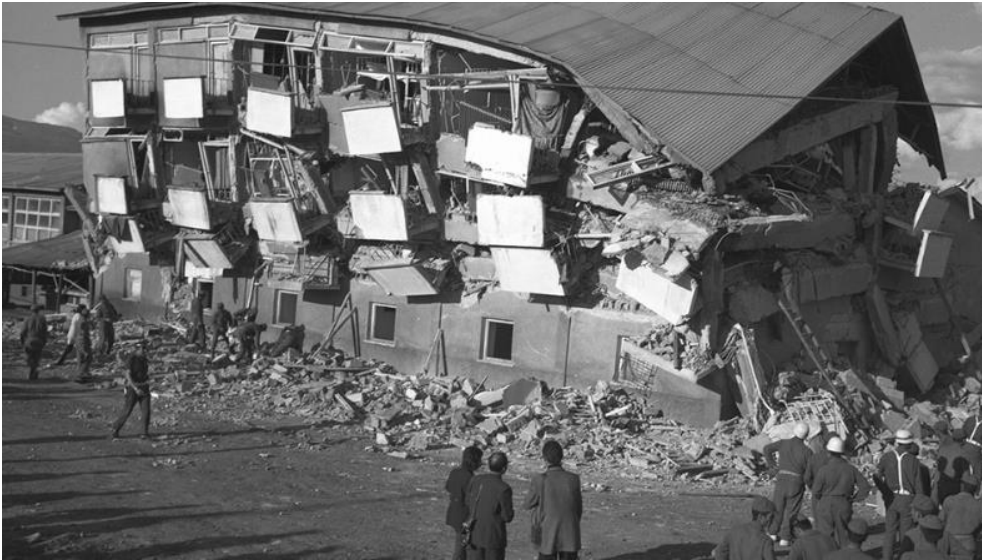
Şekil 3.6. 1971 Bingöl depreminde yıkılan YİBO (Yatılı Bölge Okulu)'da arama kurtarma çalışmalarını yürüten askeri ekipler (TRT, 2023).
