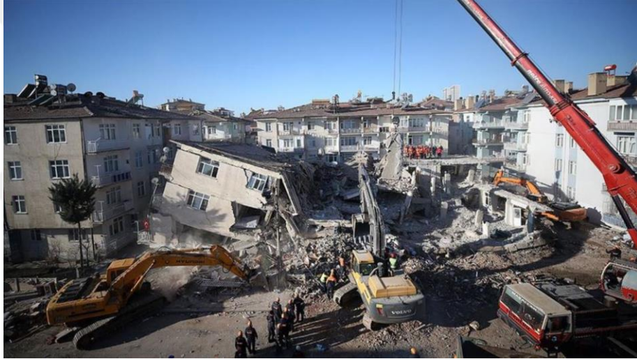
Şekil 3.28. 24 Ocak 2020 Sivrice depremi sonrasında arama-kurtarma çalışmalarında kullanılacak iş makineleri AFAD'ın koordinasyonunda görevlendirilmiş olup bunların dışındaki iş makinelerinin kullanımına izin verilmemiştir (AFAD, 2020b).
