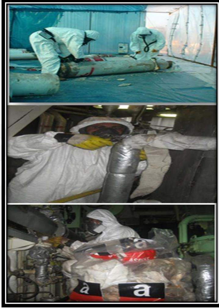
Şekil 29: Aliğa Gemi Geri Dönüşüm Sırasında Gerçekleşen Asbest Söküm İşlemlerinden Görüntüler
