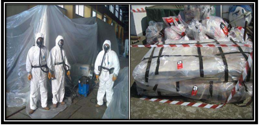
Şekil 26: Asbest Sökümüne Uygun Donatılmış Personel ve Asbest Saklama Görünümleri
