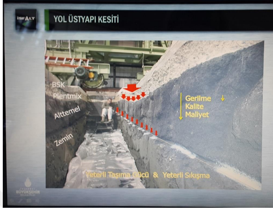
Şekil 2. Yol Üst Yapı Kesiti
