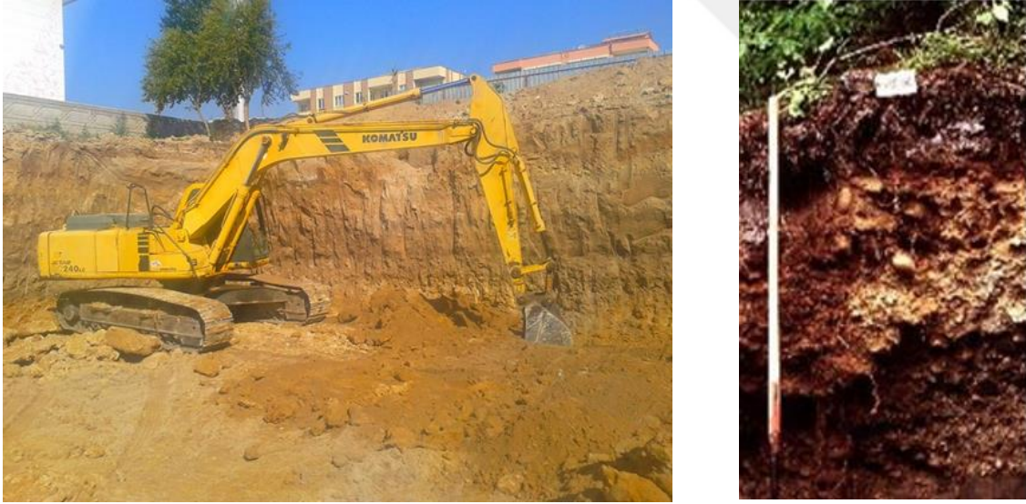
Şekil 6. Hafriyat Kazı Çalışması ve Bitkisel Toprak Kesiti
