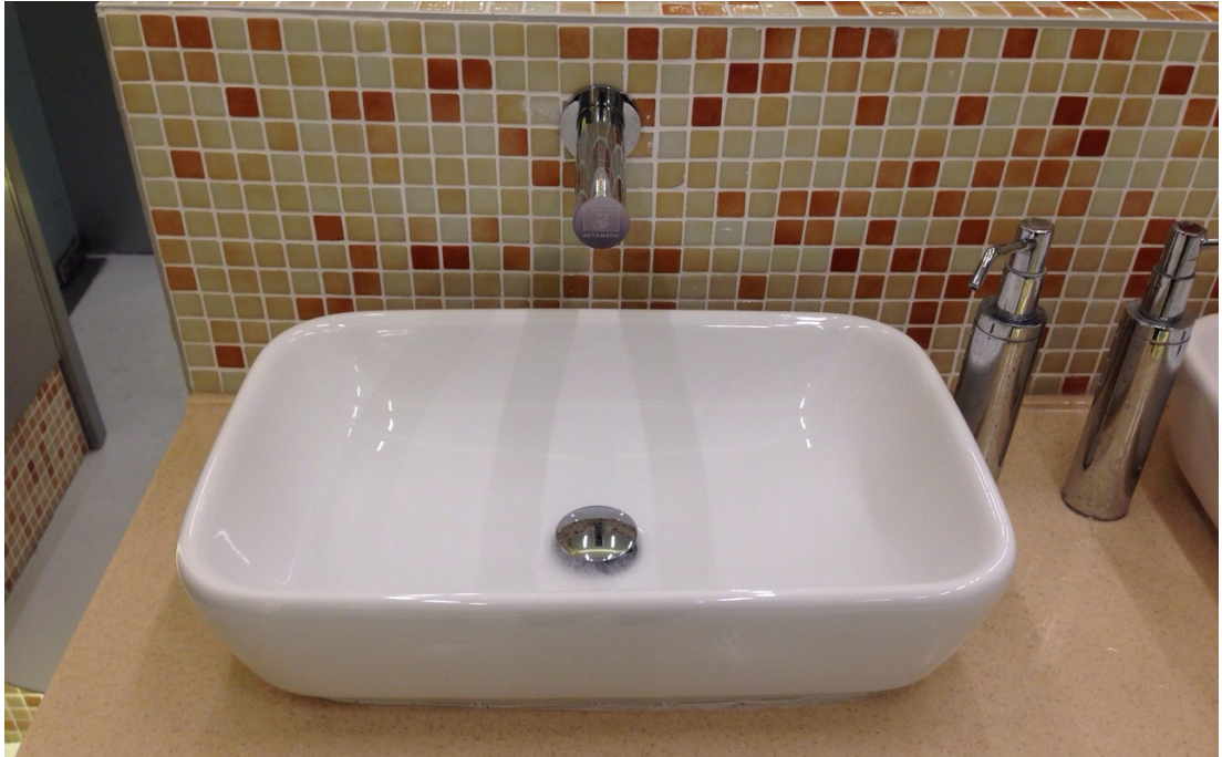
Şekil 5.24 : Kullanıcı A11’in deneyimlediği üniversite tuvaletinde bulunan fotoselli armatür.
