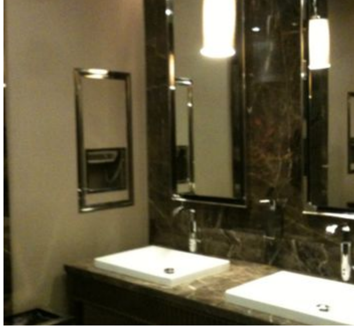
Şekil 5.17 : Kullanıcı A03’in deneyimlediği AVM tuvaletinde bulunan gömme kağıt havluluk.
