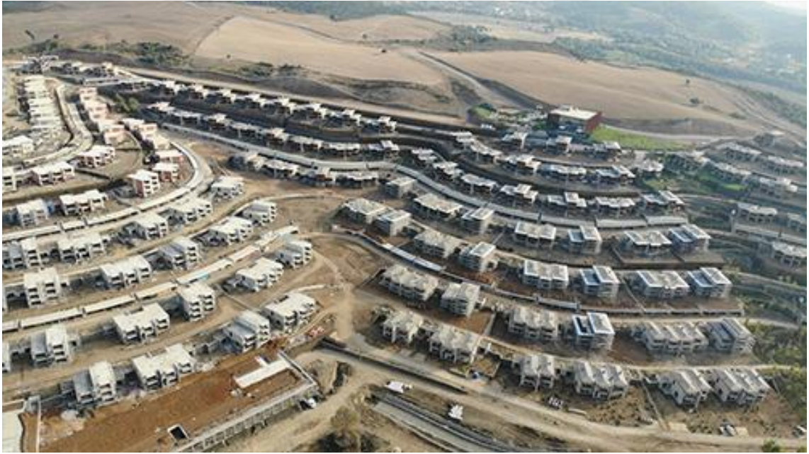
Şekil 5.49. Düşler Vadisi Konut Projesi inşaat alanı (URL 2).
