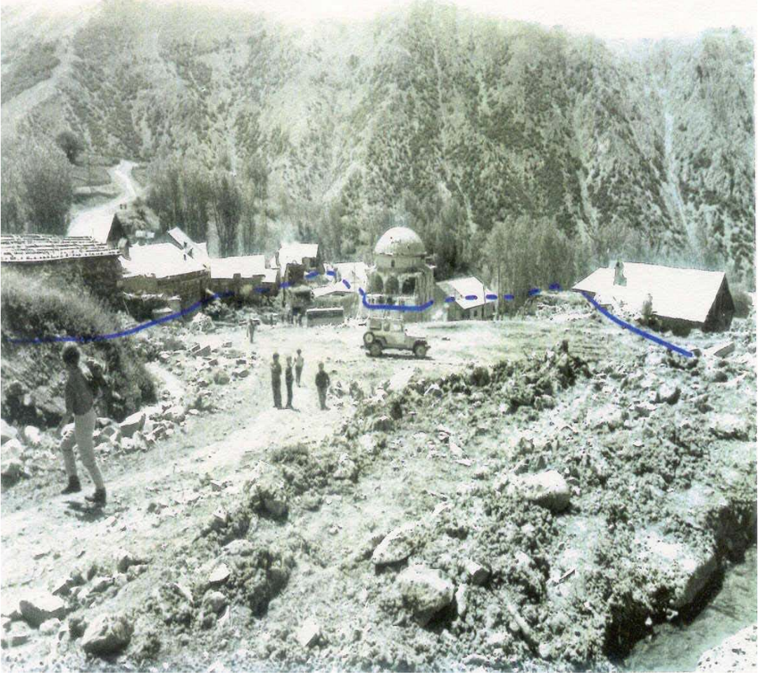
Resim 4.1. ıın etkilediėi yapıların hasar durumu
