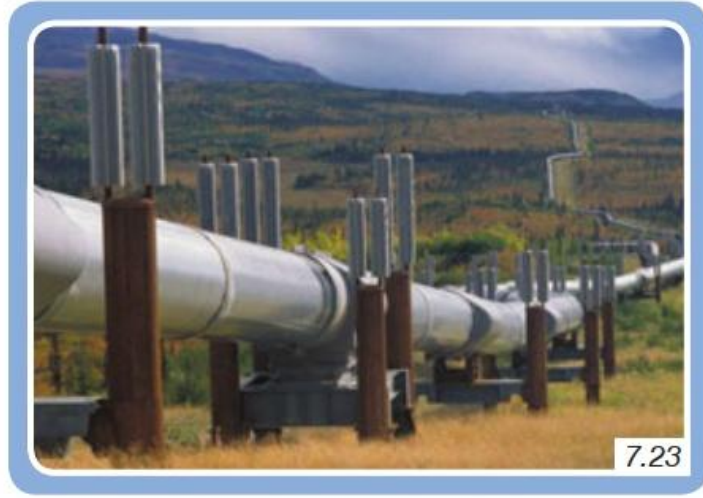
Ülkemiz petrol ve doğal gaz boru hatlarının geçtiği stratejik bir konumda bulunmaktadır.
