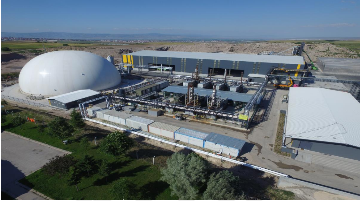
Şekil 2.1. Tesisin Genel Görünümü (1)
