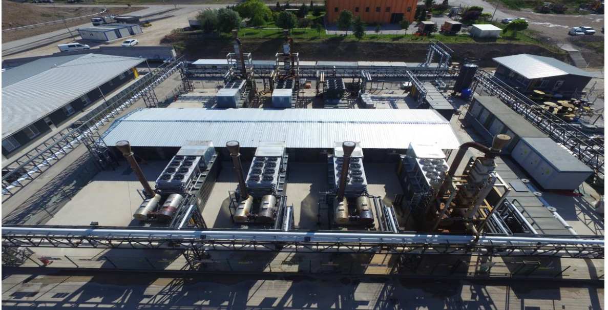
Şekil 2.2. Tesisin Genel Görünümü (2)
