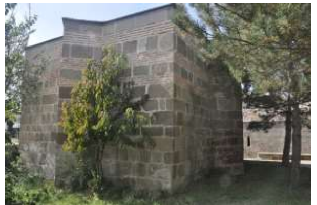
Görsel 3.10. Boyalıköy Eyvan Türbe
