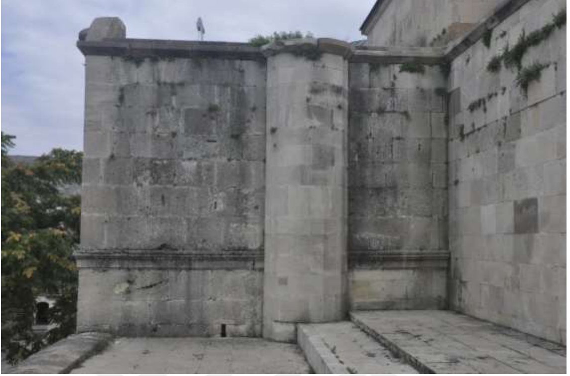
Görsel 2.18. Batı cephedeki çokgen kesitli payanda
