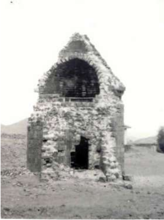
Görsel 2.152. Elti Hatun Türbesi onarım öncesi durumu
