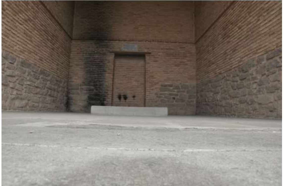
Görsel 2.46. Üst katta üç duvarı dolaşan korniş
