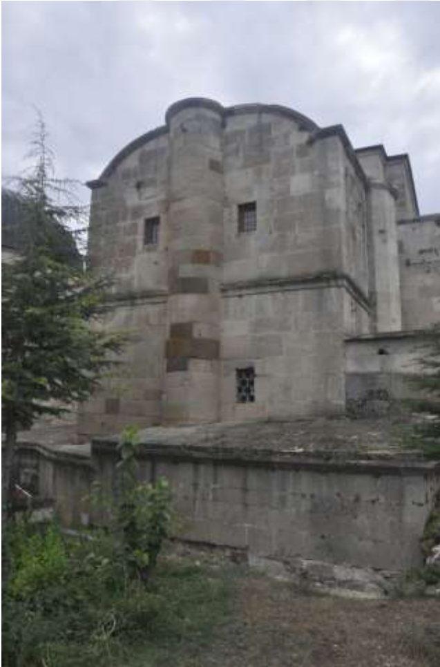
Görsel 2.18. Batı cephedeki çokgen kesitli payanda
