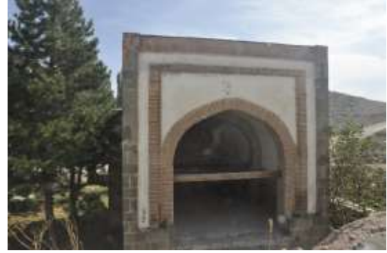
Görsel 3.6. Boyalıköy Eyvan Türbe
