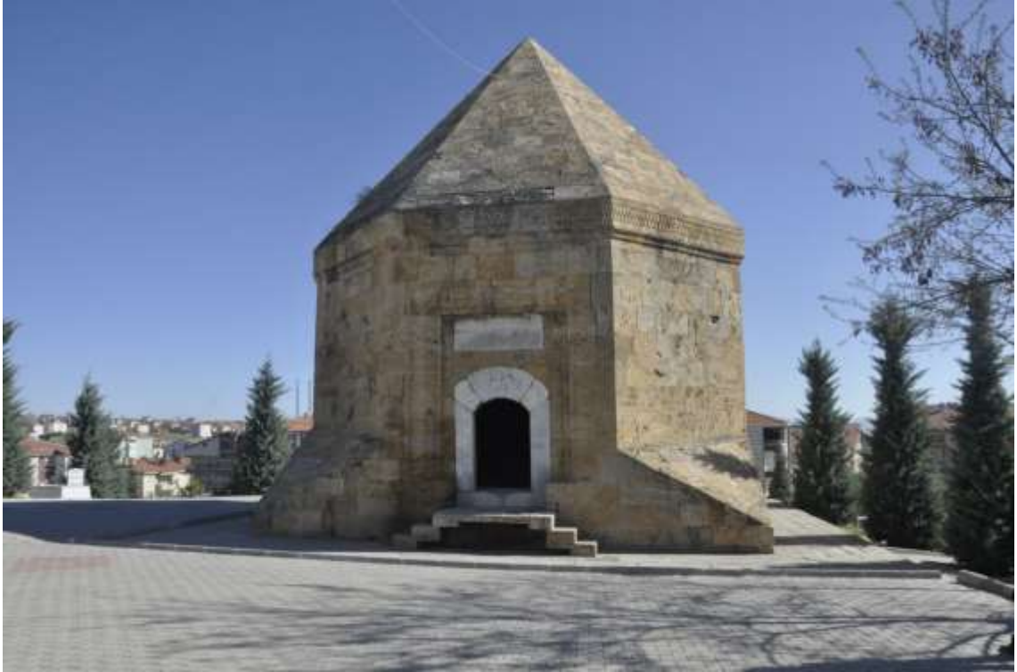
Görsel 2.119. Fatma Hatun Türbesi genel görünüm
