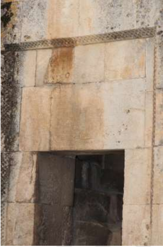
Görsel 2.227. Avlu içinde taç kapının doğusunda bulunan merdiven kuruluşu
