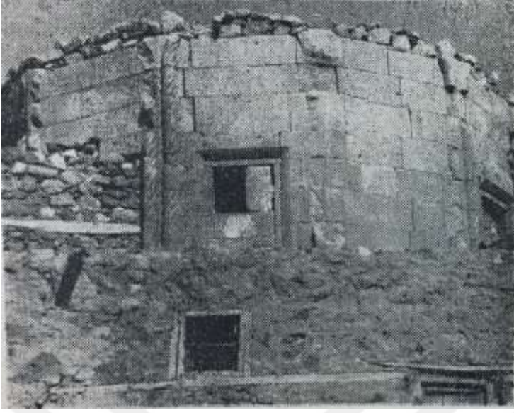
Görsel 2.198. Türbenin onarım öncesindeki durumu (Konyalı, 1960, 418)
