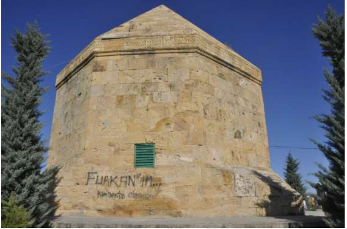
Görsel 2.122. Batı cephedeki pencere açıklığı
