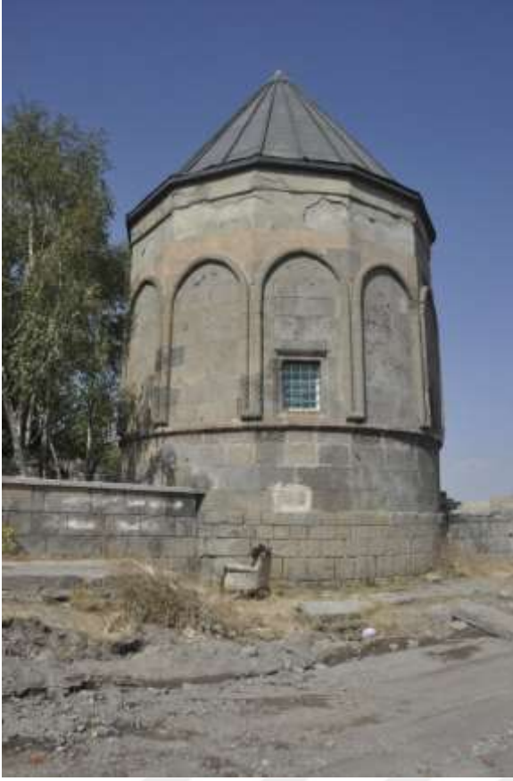
Görsel 2.200. Türbenin güneydoğu cephesi
