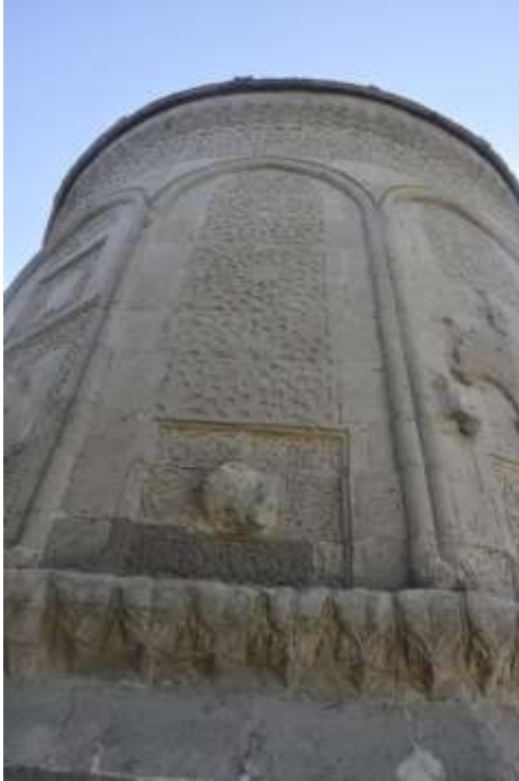
Görsel 2.192. Kuzeydoğu cephenin kuzeye bakan cephesi
