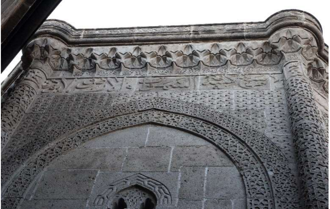
Görsel 2.103. Kuzeybatı cephe ve üst kısmı
