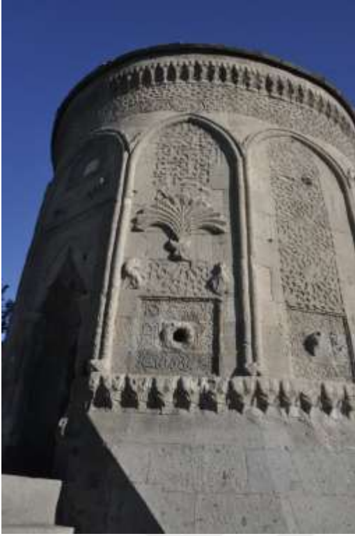
Görsel 2.186. Taç kapı cephesinin batı yanında bulunan cephe
