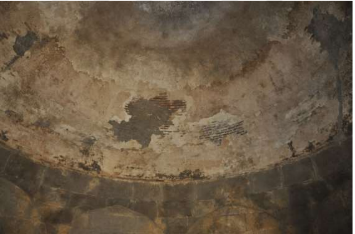
Görsel 2.129. Kubbeye geçiş ve kubbe eteği
