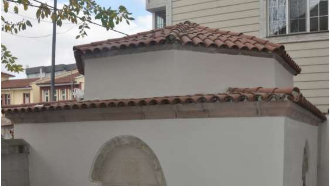
Görsel 2.244. Saçak, sekizgen prizma kasnak ve konik külah görünümü
