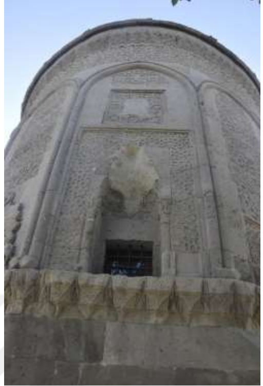
Görsel 2.191. Kuzeydoğu cephe
