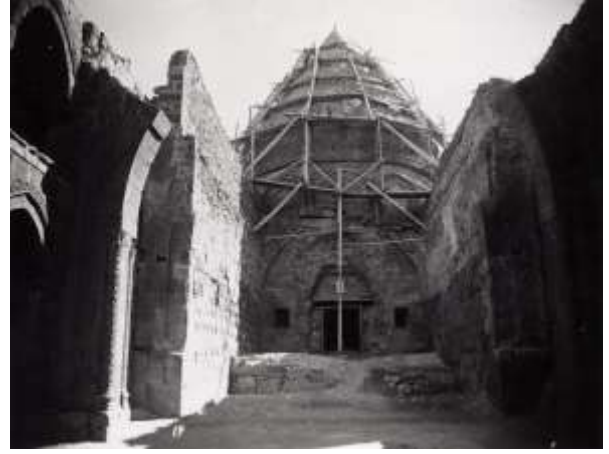
Görsel 2.162. Türbenin onarım öncesi görünümü
