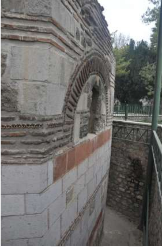
Görsel 2.52. Zemin kotu altında yer alan türbe tabanı
