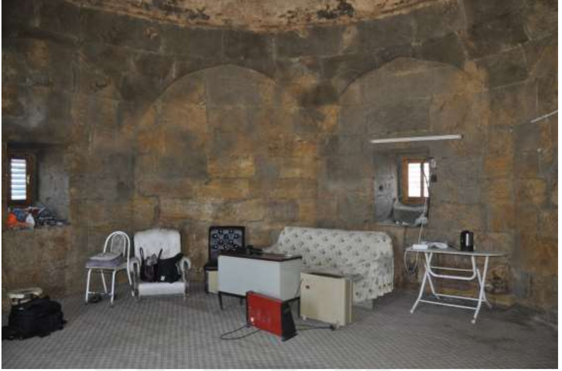
Görsel 2.128. Güney ve doğu duvardaki pencereler ile dışa taşkın sivri kemerler
