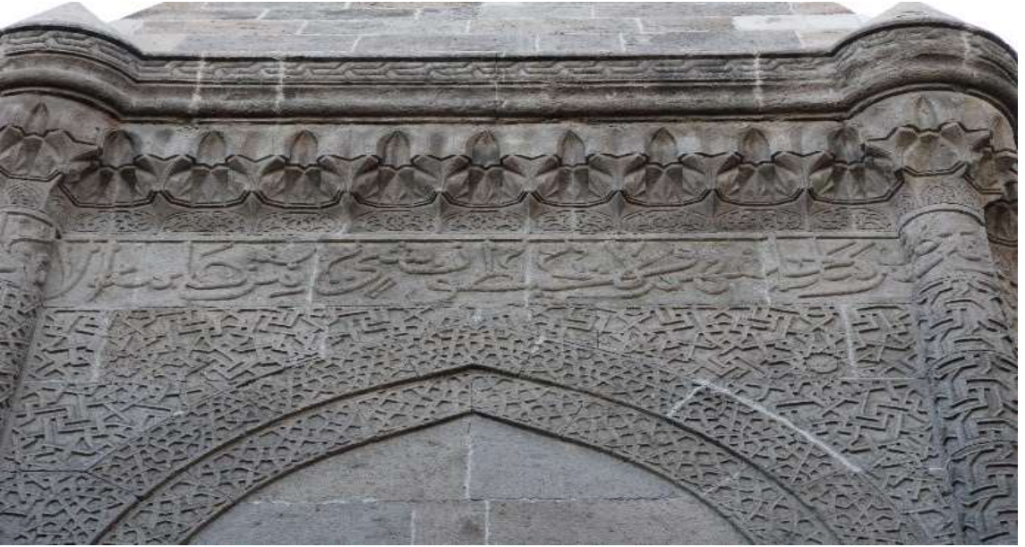
Görsel 2.105. Batı cephe üst kısım
